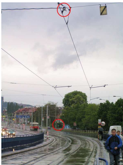
Obr.3– příklad preference tramvajové dopravy u zastávky Hloubětín
