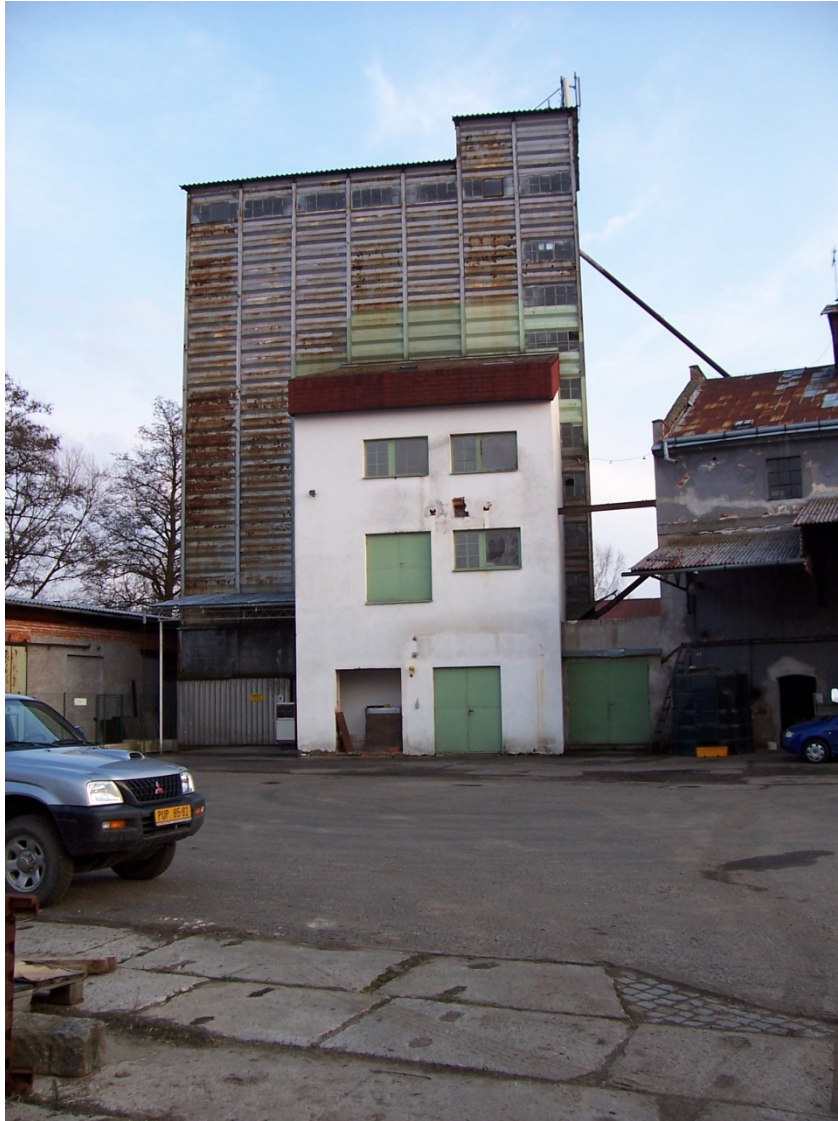
Foto 3: foceno z nádvoří severní pohled na budovu granulační linky a ocelového síla
