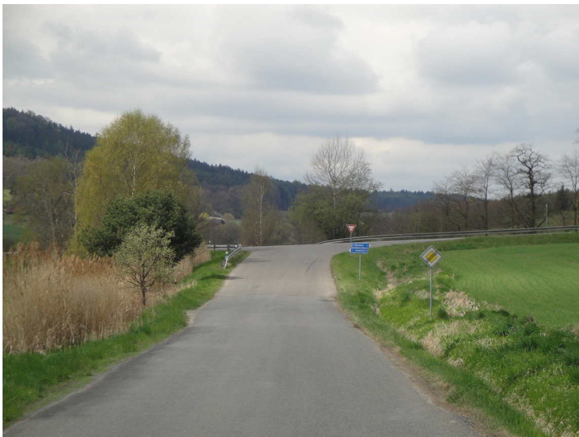
Obr. 13: Pohled od obce Řepice na křižovatku silnic II. třídy č. 173 a III. třídy č. 13913
