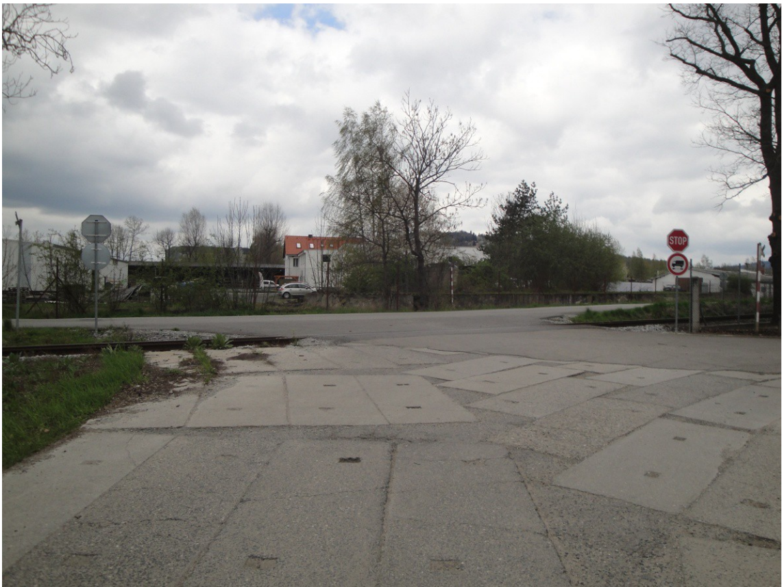
Obr. 6: Pohled na železniční přejezd trať Blatná – Strakonice. Trasa pro vozidla IZS. Pohled je vedený od Prahy do centra města Strakonice
