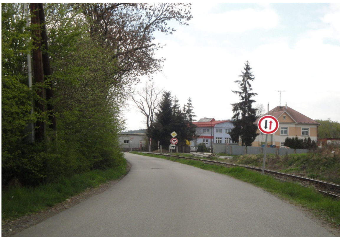
Obr. 4: Pohled k železničnímu přejezdu, trať Blatná – Strakonice. Trasa pro vozidla IZS v době uzavírky mostu. Pohled je vedený od centra města na Prahu
