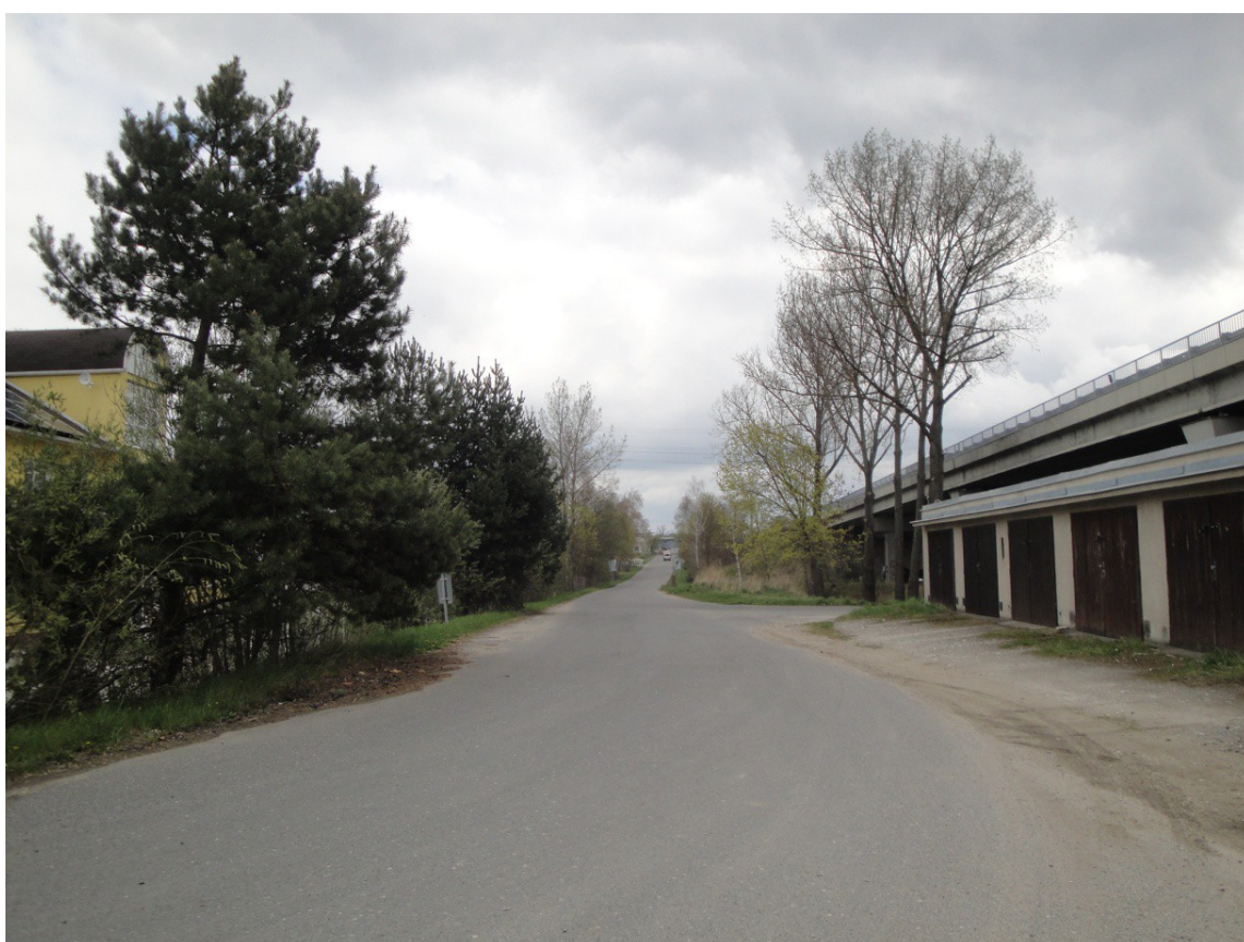
Obr. 7: Pohled na místní komunikaci vedoucí od železničního přejezdu k silnici I. třídy č. 4
