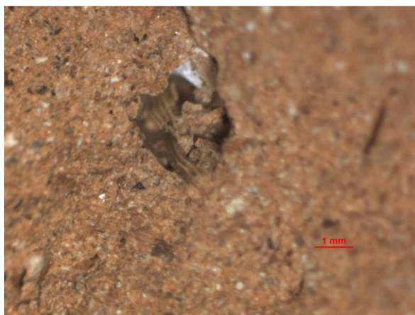
Obr. 21: Detail vyhoření odpadního kordu v cihelném střepu.
