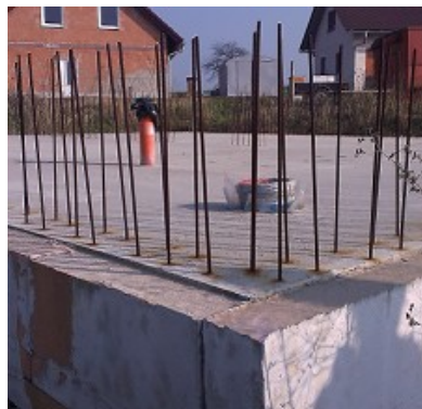
Obr. č. 15 - základová deska domu s železobetonovou konstrukcí připravenou na vnější a vnitřní zateplení. (foto autor)
