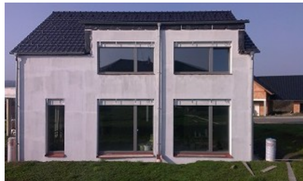
Obr. č. 13 – jižní strana (foto autor)
