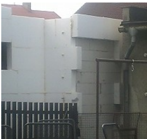
Obr. č. 2 – vnější zateplení budovy (foto autor)
