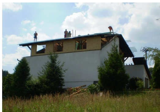
Obr. č. 25 – půdní vestavba (foto autor)
