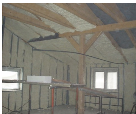
Obr. č. 4 vnitřní zateplení stěn (foto autor)
