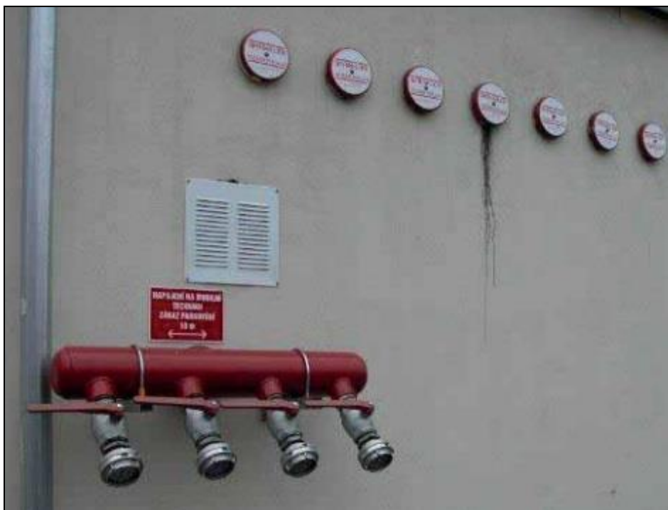
Obrázek 27: Poplachové zvony a armatura pro připojení CAS
