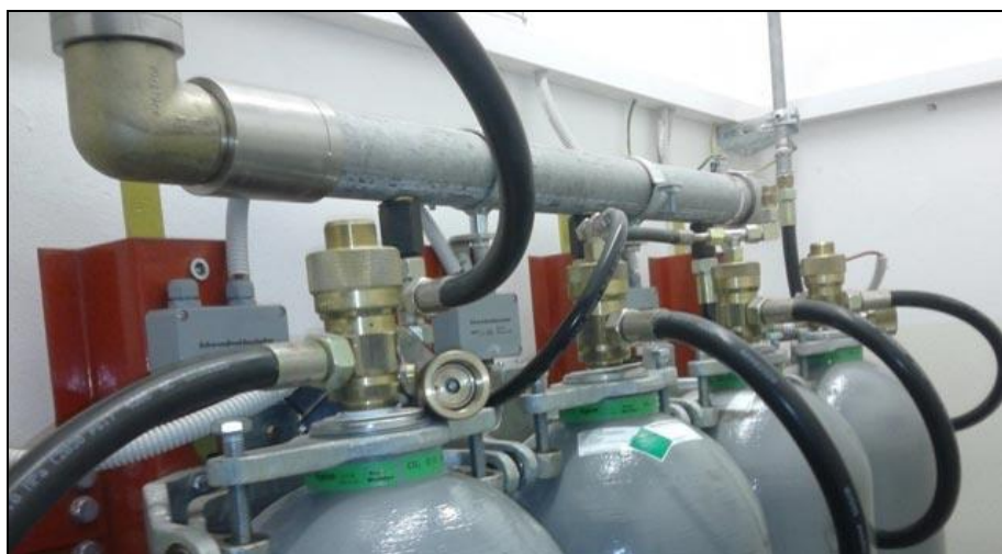
Obrázek 15: Plynová SHZ – inertní plyny – strojovna
