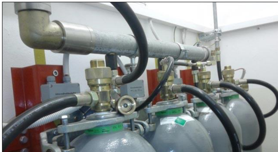
Obrázek 15: Plynová SHZ – inertní plyny – strojovna
