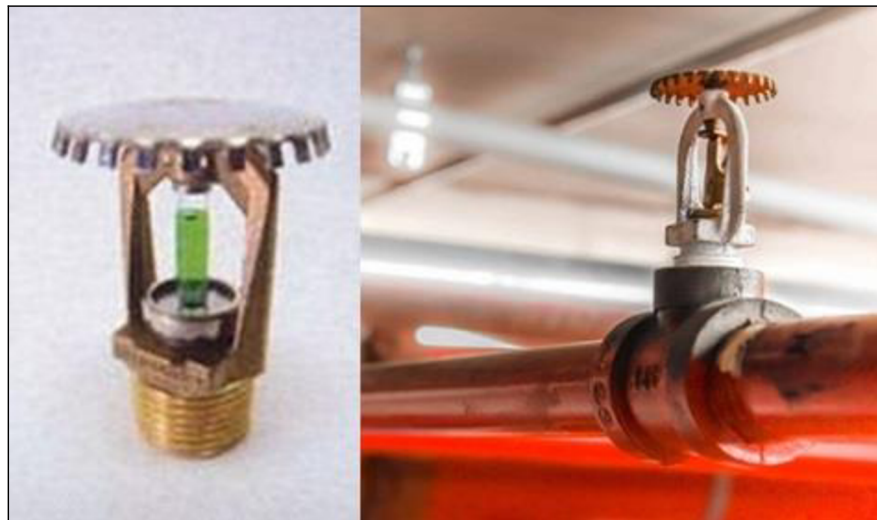
Obrázek 23: Sprinklerová hlavice stojatá
