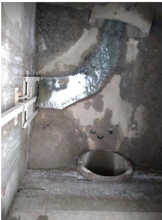
Obrázek 16: Pohled shora do OK 9 - správný stav průtoku v odlehčovací komoře za bezdeštného stavu.
