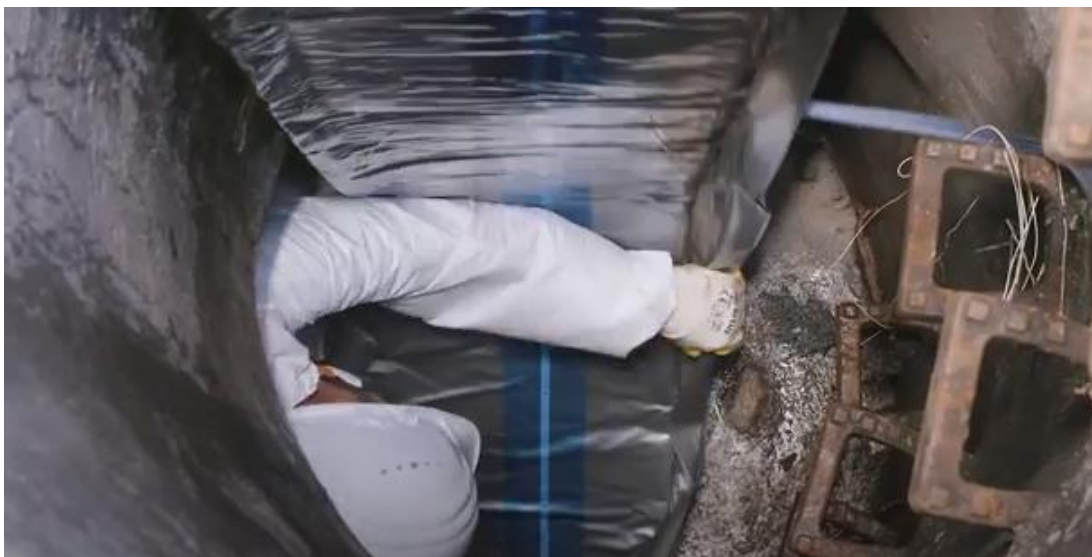
Obrázek 13: Bezvýkopové metody – zatahování rukávce šachtou do potrubí – (Brandenburger Group, ©2019).
