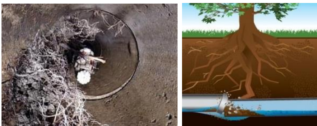
Obrázek 7: Kořeny prorostlé do průtočného profilu potrubí (Herčík a Kříž, ©2020).
