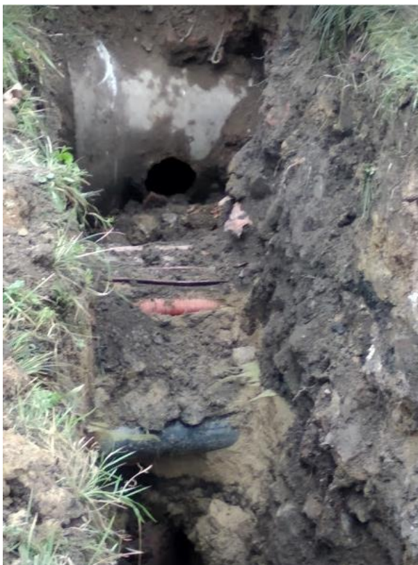
Obrázek 18: Oprava veřejné části kanalizační přípojky narušení při pokládce jiných sítí.
