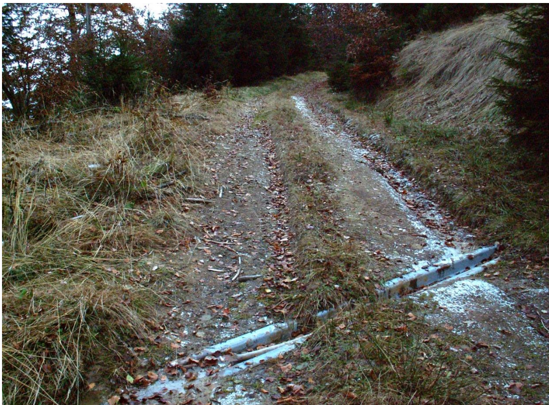
Foto 14. Odvozní cesta se zemním povrchem (třída porušenosti 3), erozní rýha, způsobená neudržovanou svodnicí (autor 2012).
