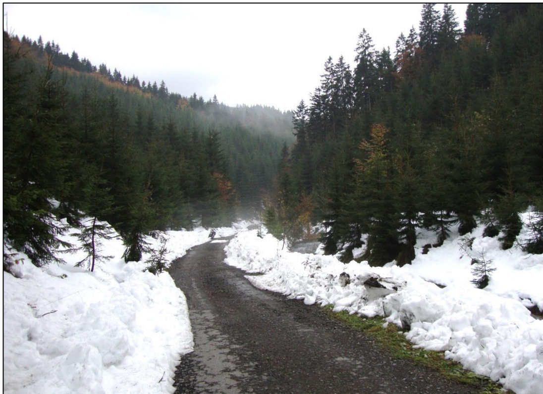
Foto 8. Odvozní cesta 1L s bitumenovým povrchem (třída porušenosti 2), ukázka zimní údržby (Tománek 2011).
