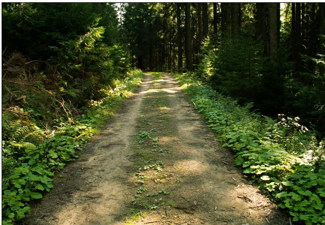
Foto 3. Kvalitní zemní odvozní cesta třídy porušenosti 1 (autor 2011).
