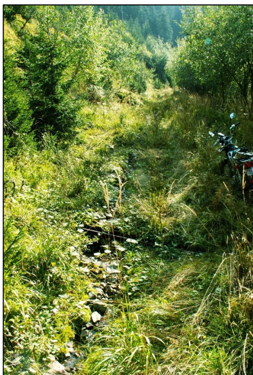
Foto 16. Odvozní cesta se zemním povrchem (třída porušenosti 4), hluboká erozní rýha, porostlá vegetací (autor 2011)
