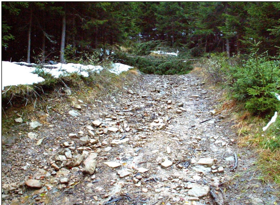
Foto 10. Odvozní cesta se šterkovým povrchem (třída porušenosti 2), úsek s plošnou erozí vozovky (zdroj autor 2012)
