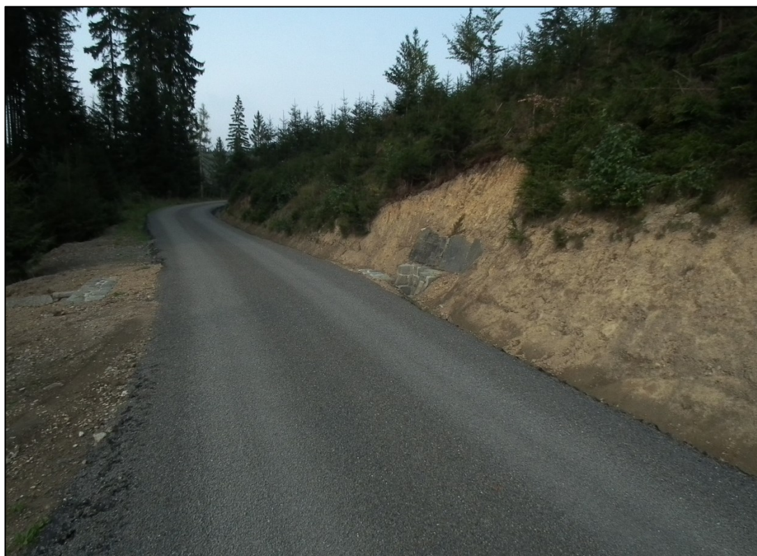
Foto 12. Odvozní cesta s bitumenovým povrchem (třída porušenosti 1), zcela nová odvozní cesta z penetrovaného makadamu s jemnější frakcí šterku (zdroj autor 2012).
