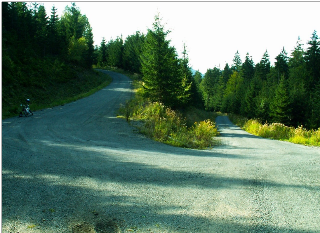
Foto 14. Odvozní cesta se zemním povrchem (třída porušenosti 3), erozní rýha, způsobená neudržovanou svodnicí (autor 2012).
