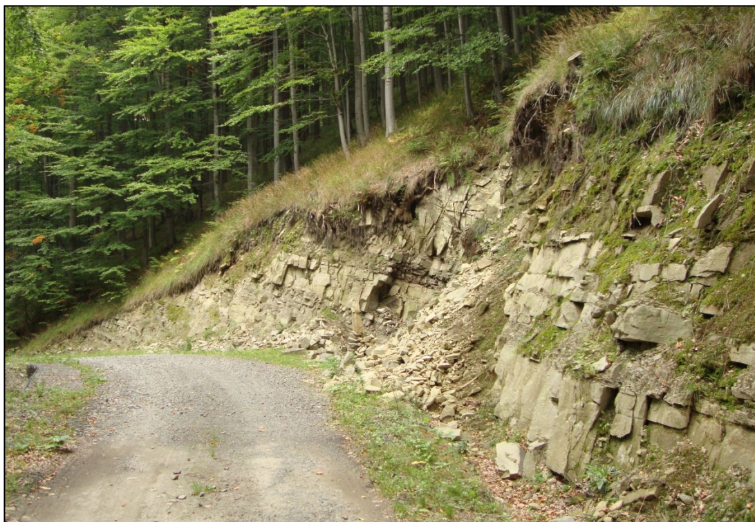
Foto 16. Odvozní cesta se zemním povrchem (třída porušenosti 4), hluboká erozní rýha, porostlá vegetací (autor 2011)
