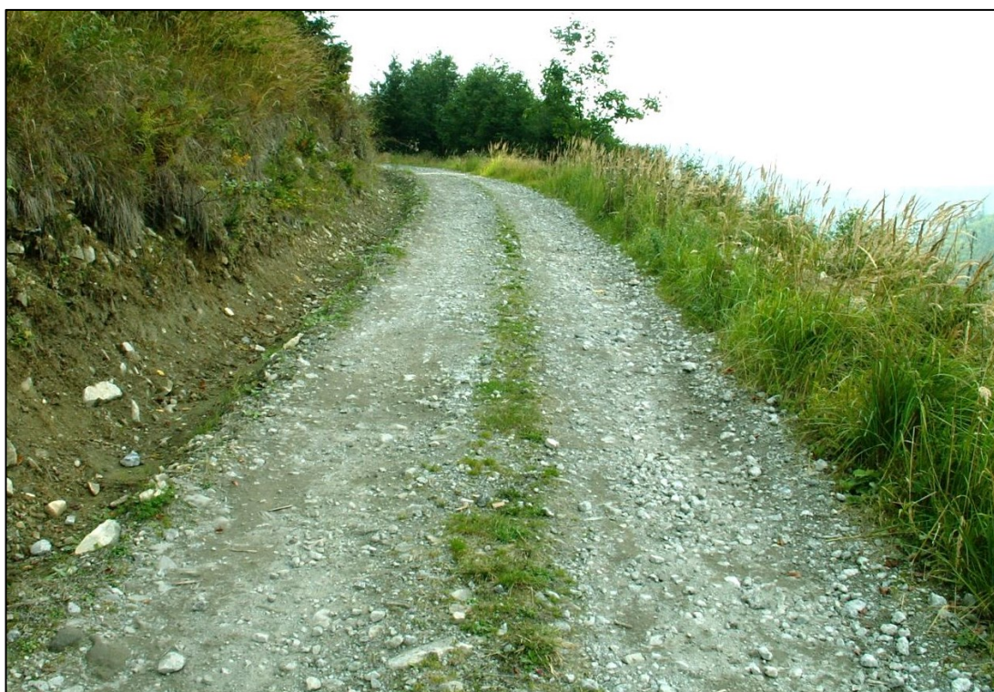
Foto 10. Odvozní cesta se šterkovým povrchem (třída porušenosti 2), úsek s plošnou erozí vozovky (zdroj autor 2012)
