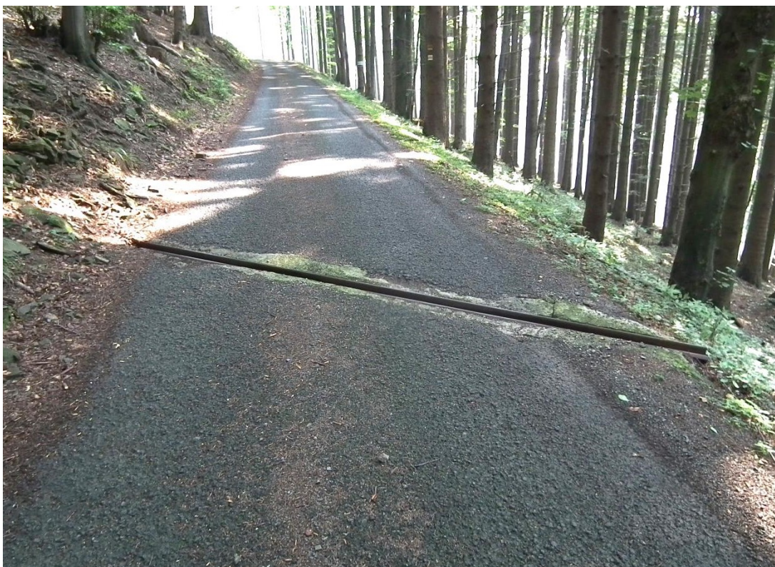
Foto 12. Odvozní cesta s bitumenovým povrchem (třída porušenosti 1), zcela nová odvozní cesta z penetrovaného makadamu s jemnější frakcí šterku (zdroj autor 2012).
