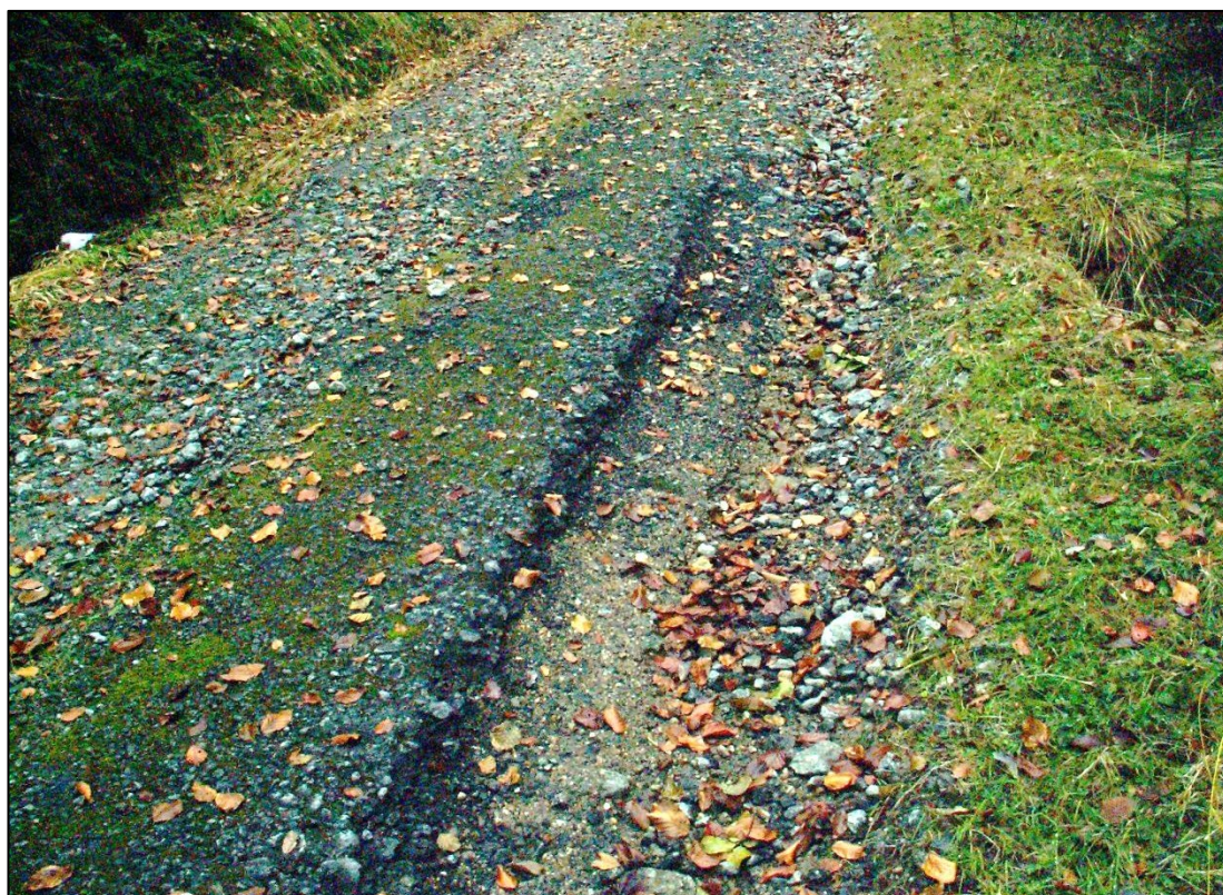
Foto 6. Odvozní cesta s bitumenovým povrchem (třída porušenosti 3), úsek s výtluky, erozí koruny a prorůstající vegetací (autor 2011).
