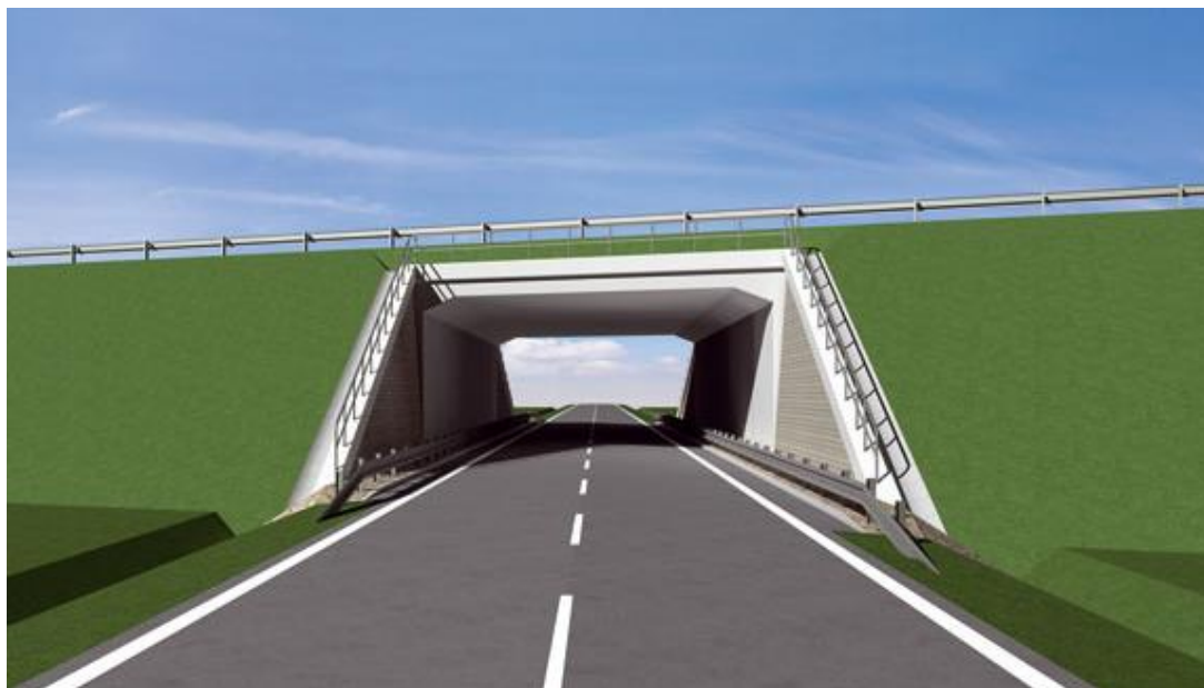
Obrázek 3 Silniční podjezd = přesypáný železniční most
