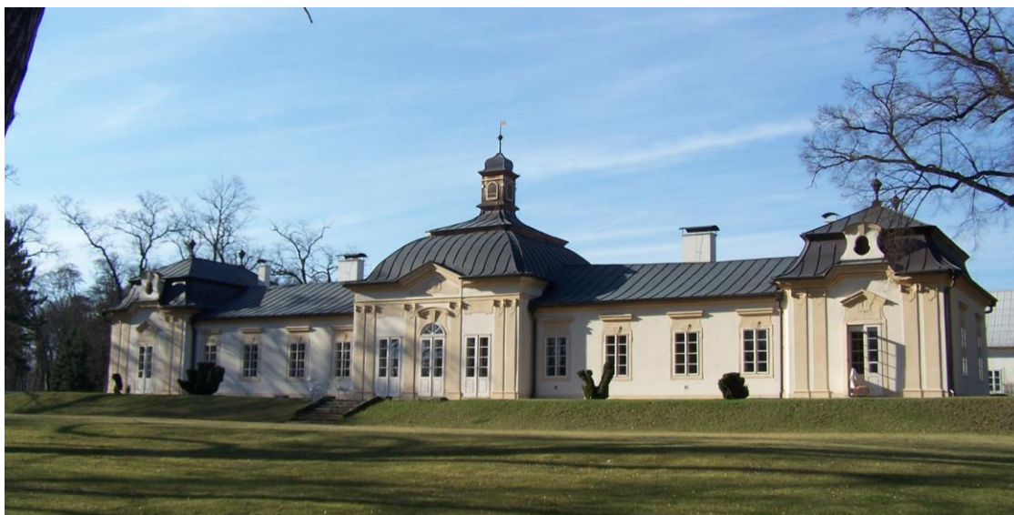
Obr. č. 10b. Nový zámek od jihu. – Foto autor (2012).
