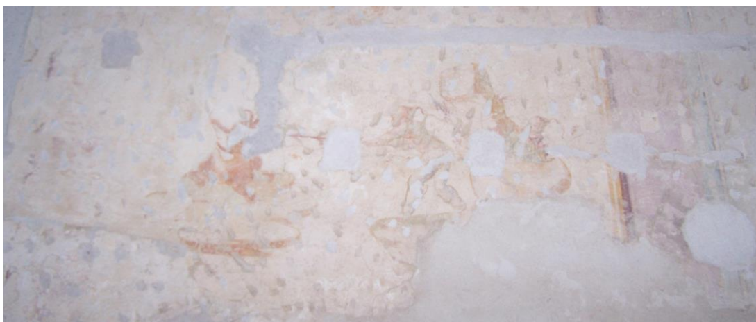
Obr. č. 37. Restaurování interiérových fresek v západním křídle Starého zámku. – Foto autor (2016).
