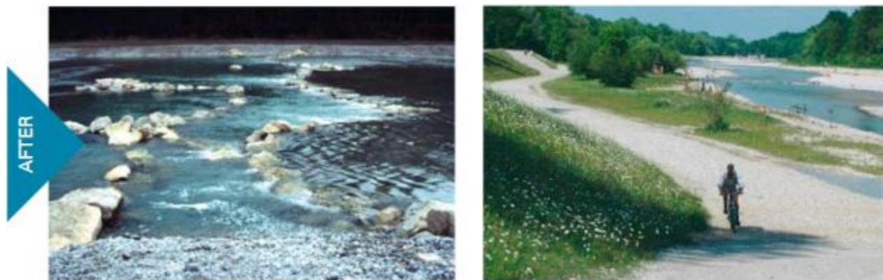
Obr. 38-39 Po: umělé rovné říční prahy byly nahrazeny nízkými a členitými, poskytujícími ochranu pro vodní faunu. Také byly přestavěny staré pobřežní hráze tak, aby byla zlepšena protipovodňová funkce a zlepšen celkový vzhled a současně aby byly zachovány stávající vzrostlé stromy Obr. 36-39 Zdroj: www.muenchen.de/dam/isar-plan_flyer_en [cit. 2021-03-27]
