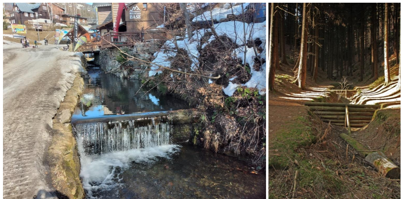
Obr. 94 – 95 Příklady dřevěných přehrážek. Vlevo Rokytnice n.Jiz, vlastní foto, vpravo Ralsko, https://www.jiritaus.cz/fotky/1665-hrazeni-bystriny-pod-nedamami
