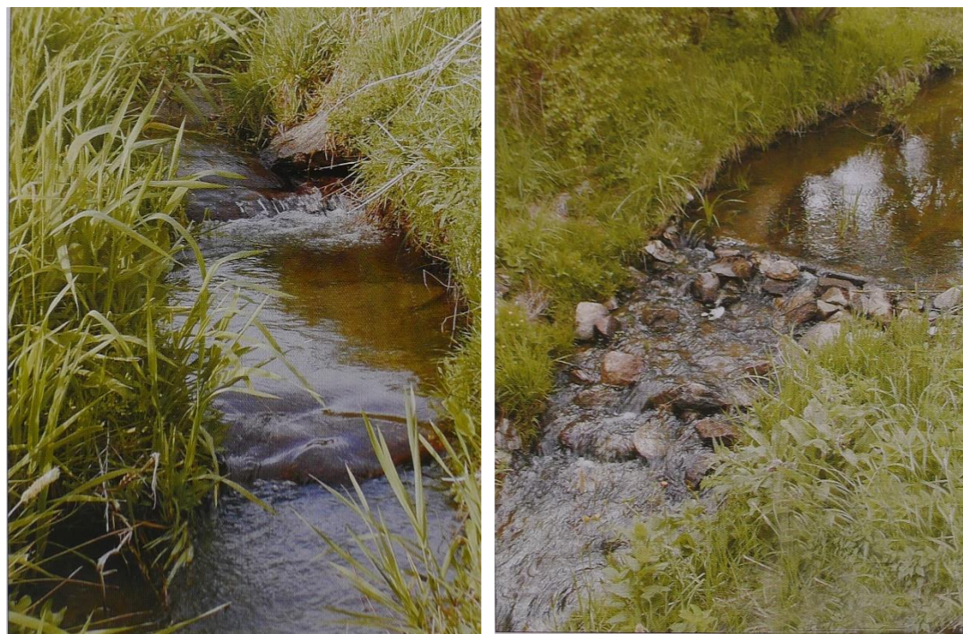
Obr. 88 (vlevo) Vložení velkých izolovaných kamenů do koryta bez opevnění – pozitivní efekt na stabilizaci koryta a diverzifikaci podmínek (Milná, revitalizovaná v 2001)
