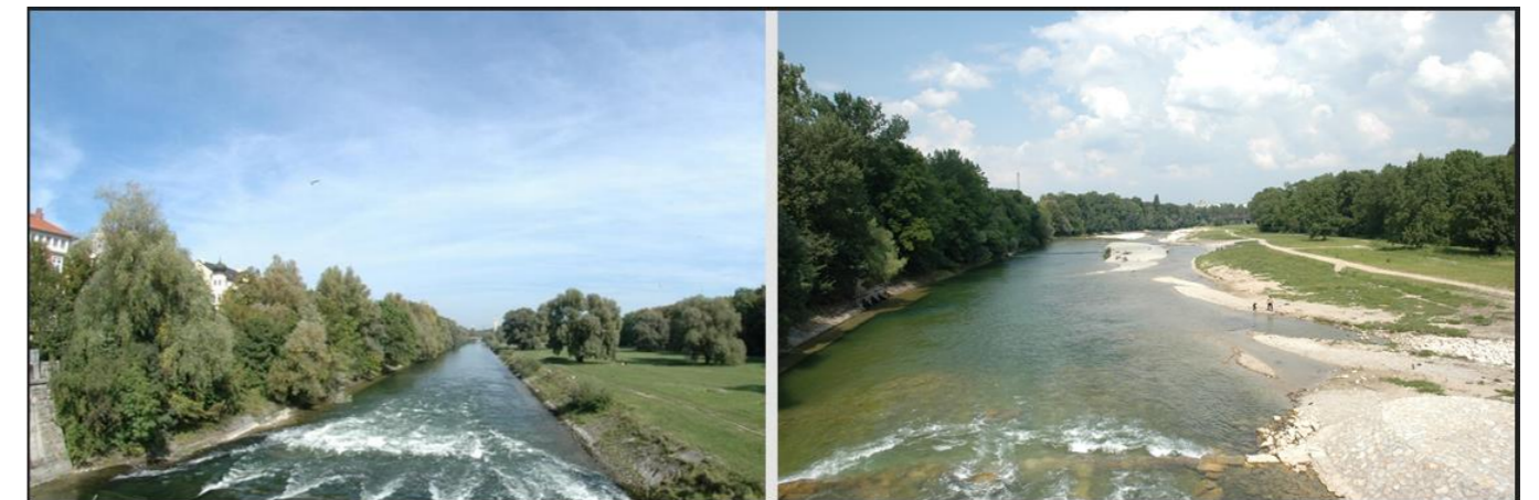
Obr. 42-43 Původní regulovaný Isar (vlevo) a obnovený diverzifikovaný kanál (vpravo) Zdroj: https://restorerivers.eu/wiki/index.php?title=Case_study%3AIsar-Plan [cit. 2021-03-27]
