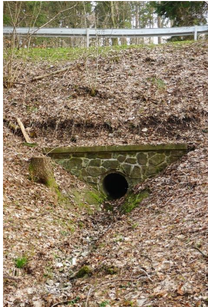
Obr. 65 Vyústění pod silnicí
