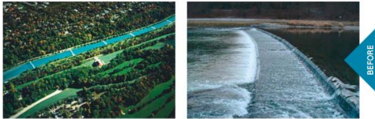
Obr. 36-37 Před: Série říčních prahů vystavěných v řece každých 200 metrů, zpomalujících rychlost proudění a eroze v narovnaném korytě, znemožňující rybám migraci i nalezení úkrytu. V obdobích nízkého nebo středního stavu vody se z Isary stala série přehrazených rybníčků
