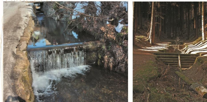
stabilizační přehrážka - kulatina zaražená do dna, která drží další klády, seříznuté do hranolu, umístěné vodorovně a zapuštěné do břehů Zdroj: vlevo vlastní foto, vpravo internet
