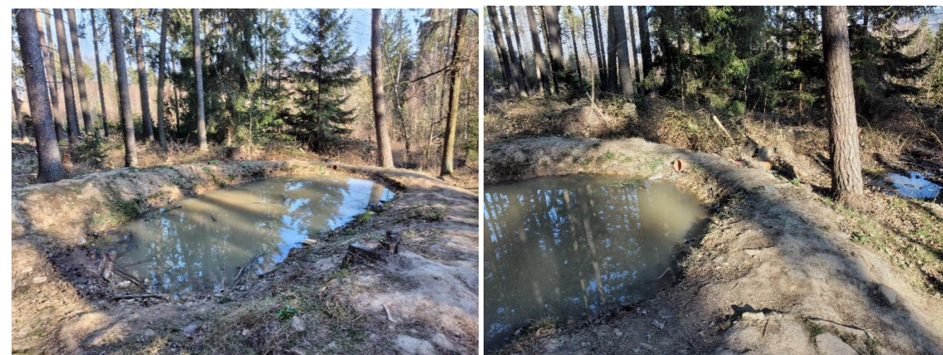
Obr. 96 – 97 Zde k nepropustnosti retenční nádržky stačil pouze místní jíl, ač je umístěna v kopci, na dočasném toku (v době focení suchém) a focena v době déle trvajících sucha. Úbočí Plešivce, Brdy vlastní foto
