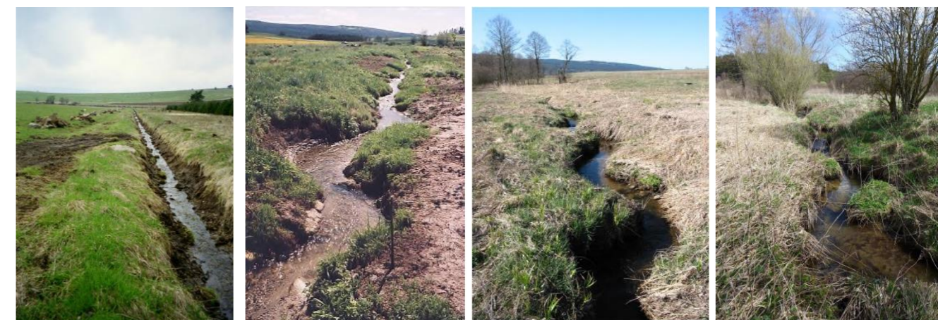
Obr. 10-13 Revitalizace Milné – po odstranění betonových desek v 2000 / rok 2001, střídavě umístění skupiny kamenů v březích překryté drnovými čepičkami / rok 2004 / jaro 2018 (Just, 2018)
