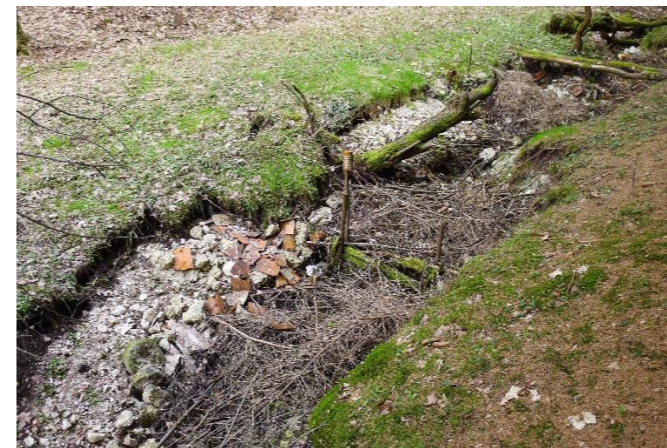
Obr. 72 Erodovaná část koryta a snaha o nápravu závážkou
