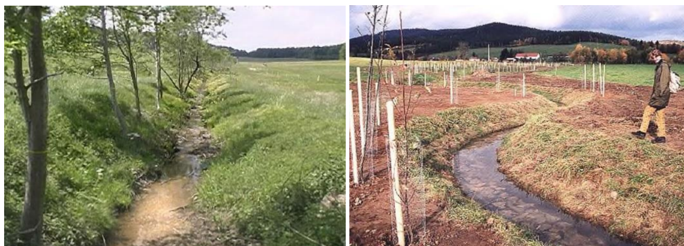
Obr. 6-7 Revitalizace Borové – vlevo původní stav, vpravo nové koryto těsně po vytvoření, 2000 (Just, 2018)
