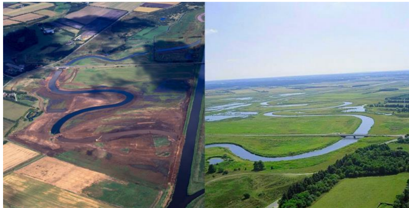
Obr. 54-55 Pohled na Skjern během (vlevo) a po (vpravo) revitalizaci. Zdroj: https://restorerivers.eu
