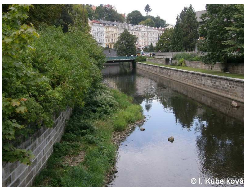
Obr. 11: Lokalita č. KV-31 v korytě řeky v centru města Karlovy Vary
