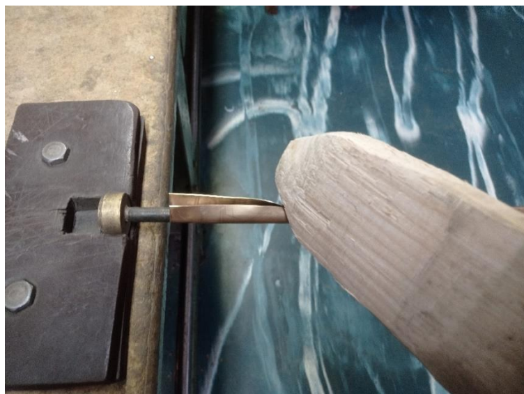
Obr. 30 – Sklepávání trubice dřevěnou paličkou
