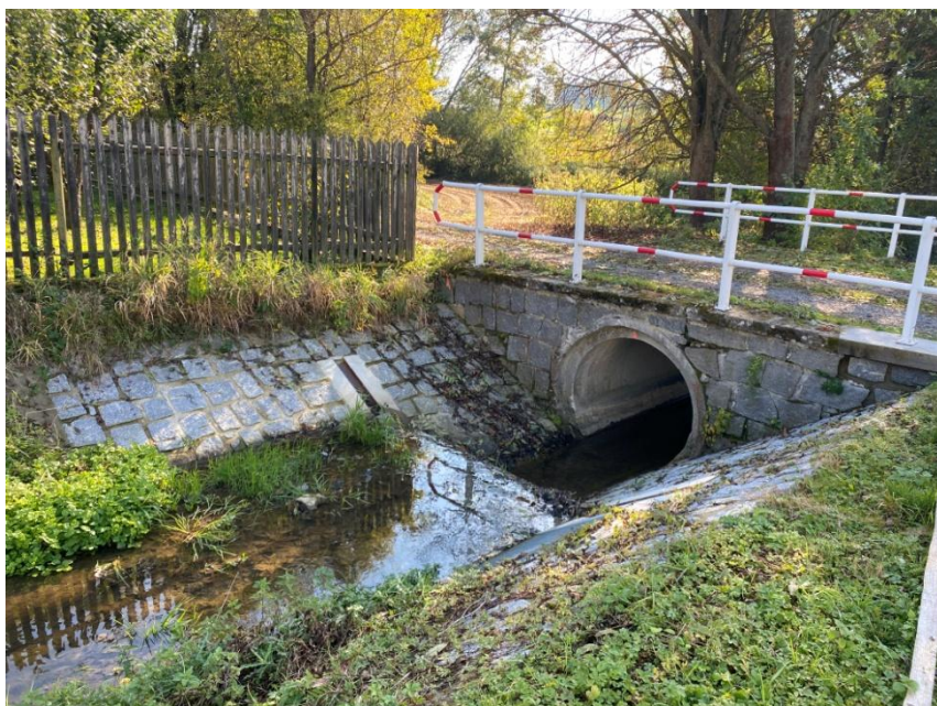
Obr. č. 20 – mostek a propustek u hlavní polní cesty 2; vlastní foto dne 17. 9. 2021
