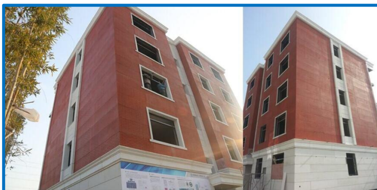
Obrázek 11 - Vytištěný podlažní bytový dům od společnosti WinSun [48]
