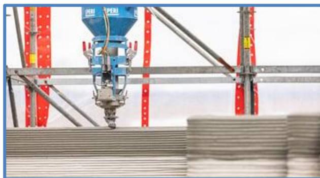
Obrázek 35 - Tisková hlava s nádobkou na směs [55]
