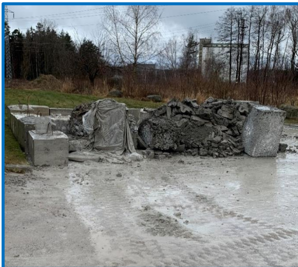
Obrázek 41 - Skladiště nedokonale zhomogenizované směsi
