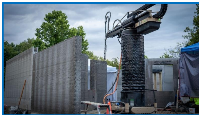
Obrázek 13 - Frank, modifikovaný průmyslový robot [13]
