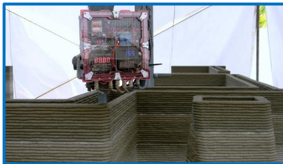
Obrázek 49 - Tisková hlava modelu StroyBot 6.2 [15]
