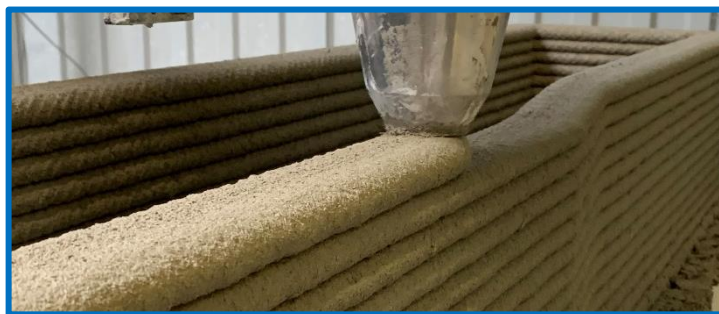
Obrázek 3 - Nanášení vrstvy
