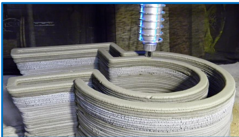
Obrázek 17 - Extruze betonu [15]
