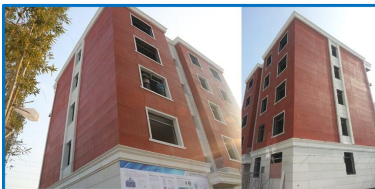
Obrázek 11 - Vytištěný podlažní bytový dům od společnosti WinSun [48]
