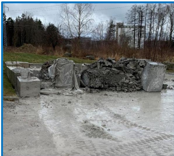
Obrázek 41 - Skladiště nedokonale zhomogenizované směsi
