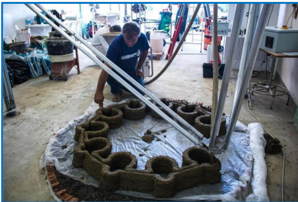
Obrázek 8 - Proces tisku na tiskárně typu Delta [45]
