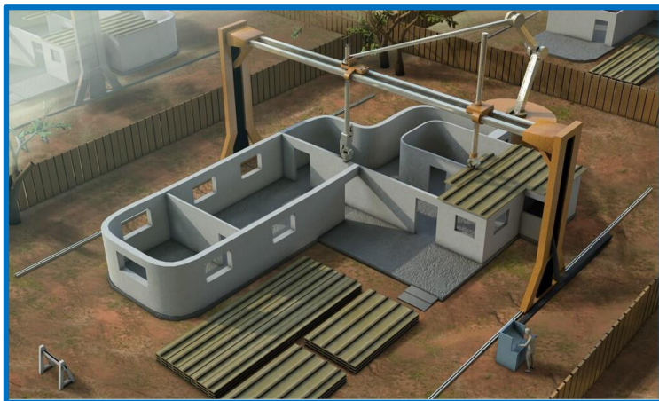
Obrázek 4 - Metoda Contour Crafting [43]
