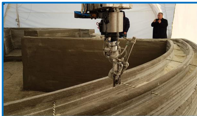
Obrázek 14 - Horizontální zpevnění výtisků [50]
