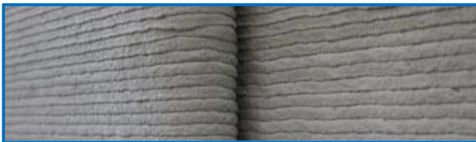
Obrázek 23 - Detail tištěné stěny z materiálu CyBe Mortar; upraveno dle [18]
