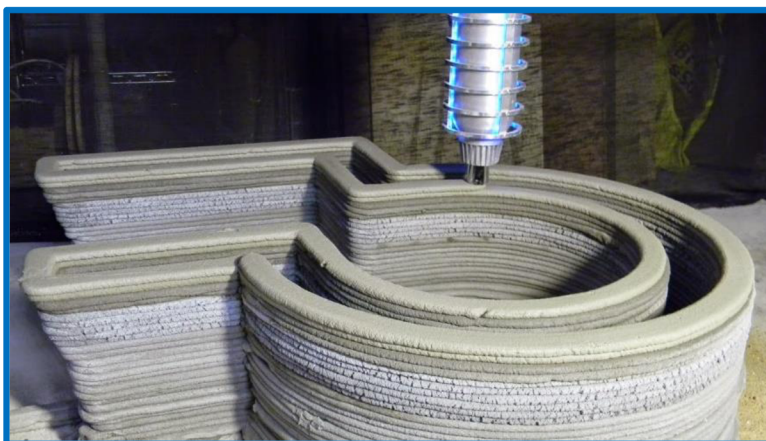
Obrázek 17 - Extruze betonu [15]
