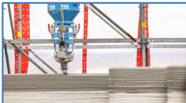
Obrázek 35 - Tisková hlava s nádobkou na směs [55]
