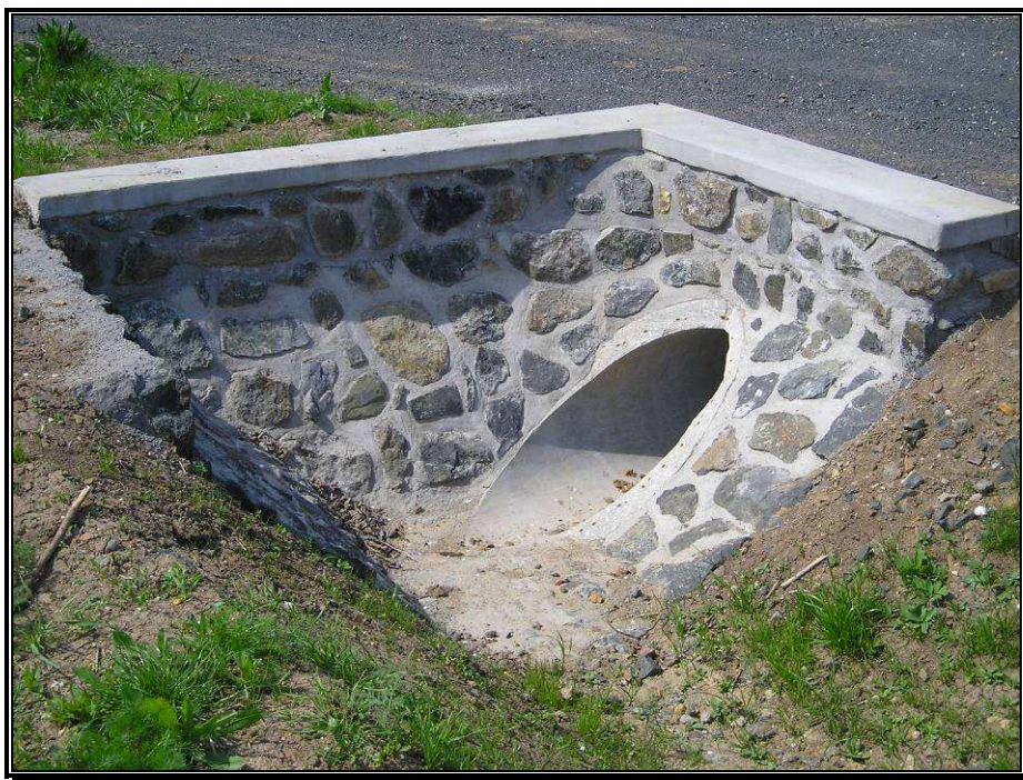
Foto č. 11: Bžany VPC 16, odvodňovací příkop s propustem, foto Halamová M., dne 15. 10. 2011
