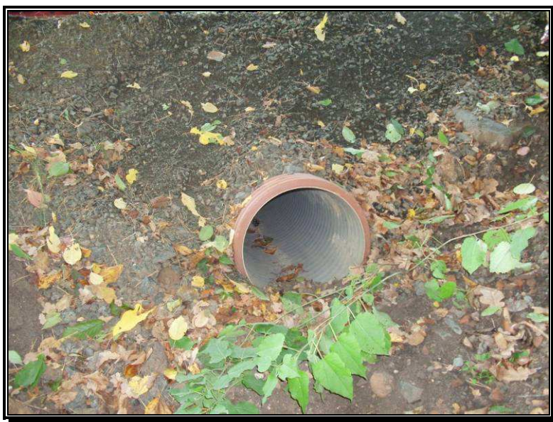
Foto č. 26: Polní cesta C5, trubní propustek pod cestou, foto: Halamová M., 15. 10. 2011
