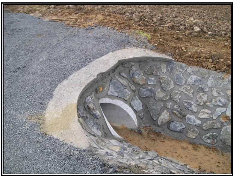
Foto č. 9: Bžany - VPC 2, příkop, propustek a sjezd, foto Halamová M., dne 15. 10. 2011
