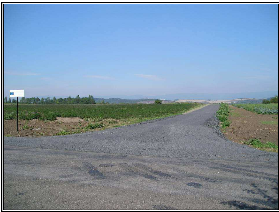
Foto č. 1 : Bžany HPC 1 - v místě napojení na silnici III/25821 do Kostomlat p. Milešovkou, Halamová M., dne 5. 10. 2011
