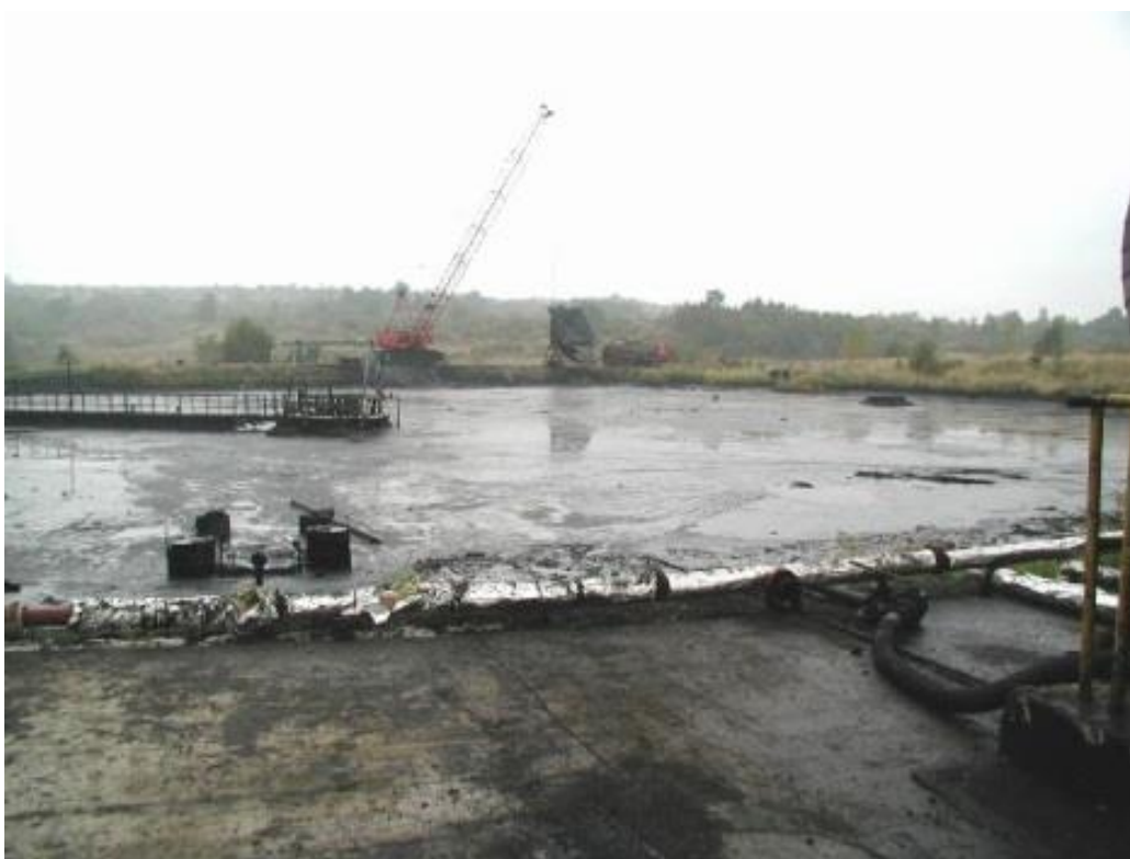
Obrázek č. 5: Těžba ropných a dehtovitých materiálů z laguny R 3
