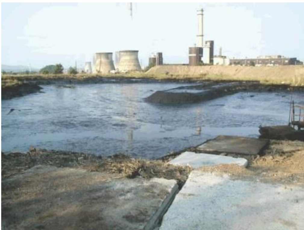
Obrázek č. 2: Laguna R 8a před sanací
