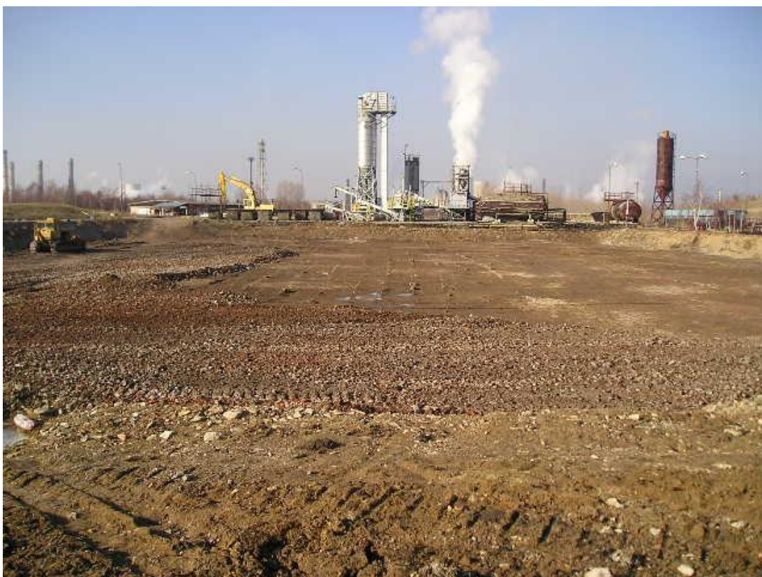
Obrázek č. 7: Laguna R 3 po ukončení prací
