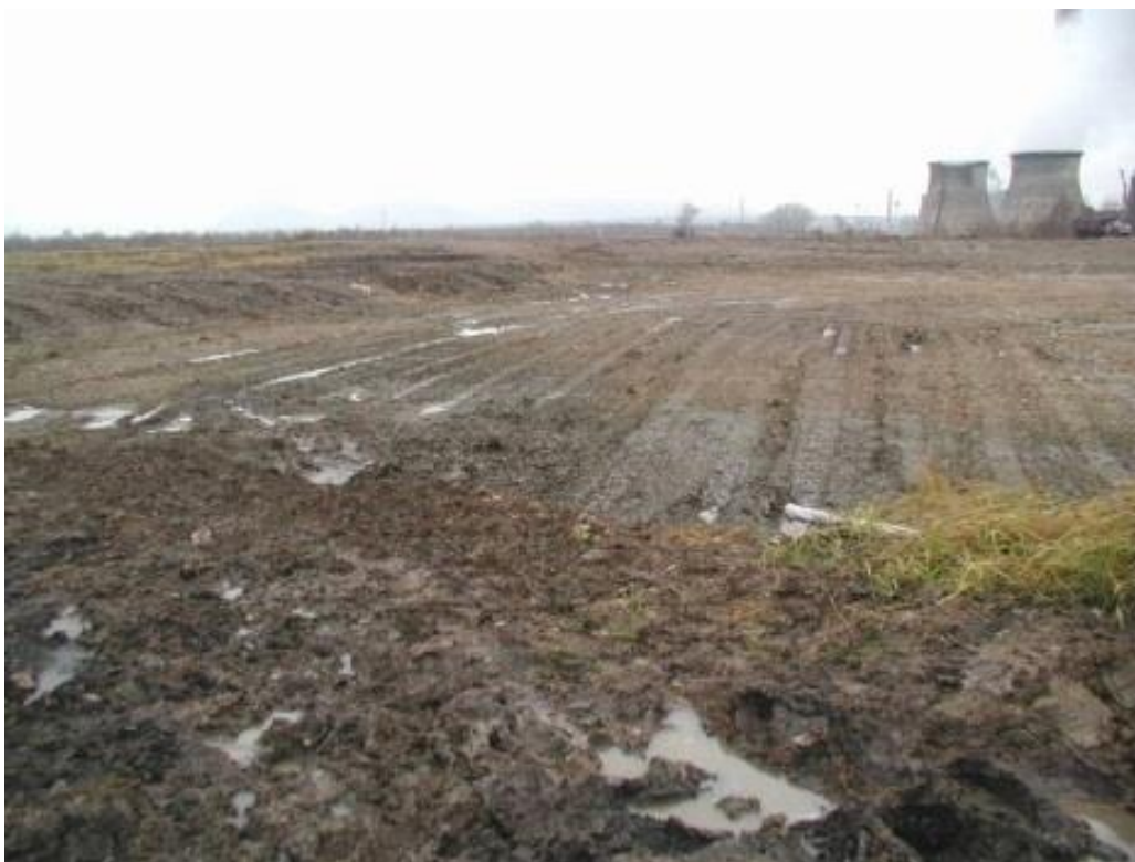
Obrázek č. 3: Stav laguny R 8a po dokončení prací
