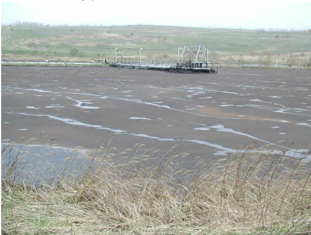
Obrázek č. 4: Původní stav laguny R 3
