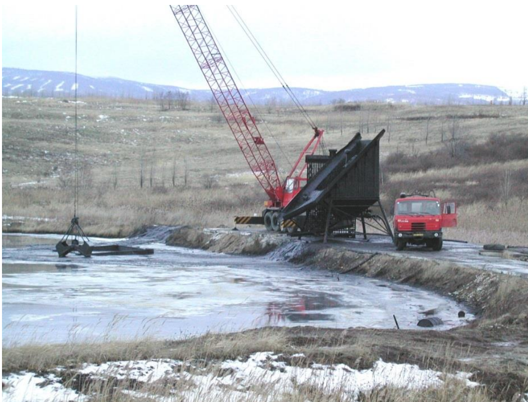
Obrázek č. 9: Těžba dehtovitých materiálů z laguny R 4
