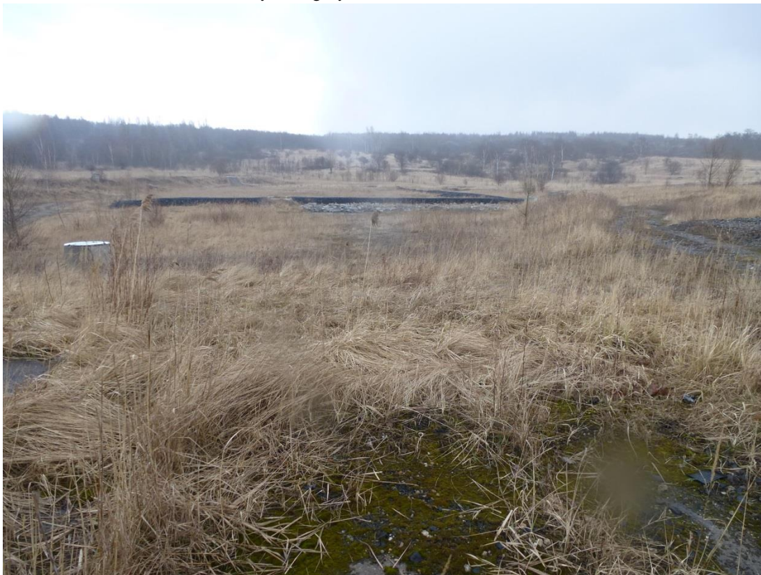
Obrázek č. 12: Aktuální stav v místě bývalé laguny R4
