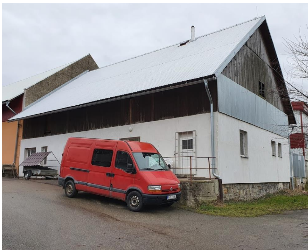
Obr. 50 Exteriér výrobní dílny 2.
