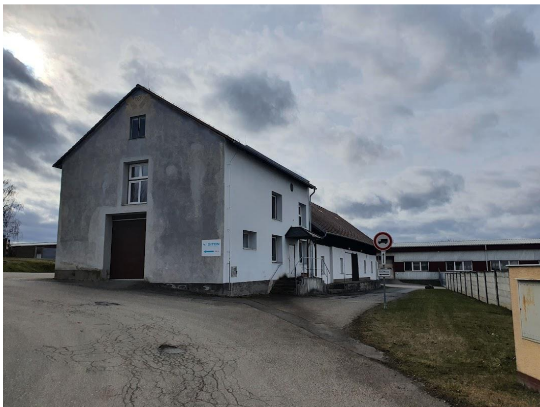
Obr. 59 Exteriér výrobní dílny 3.
