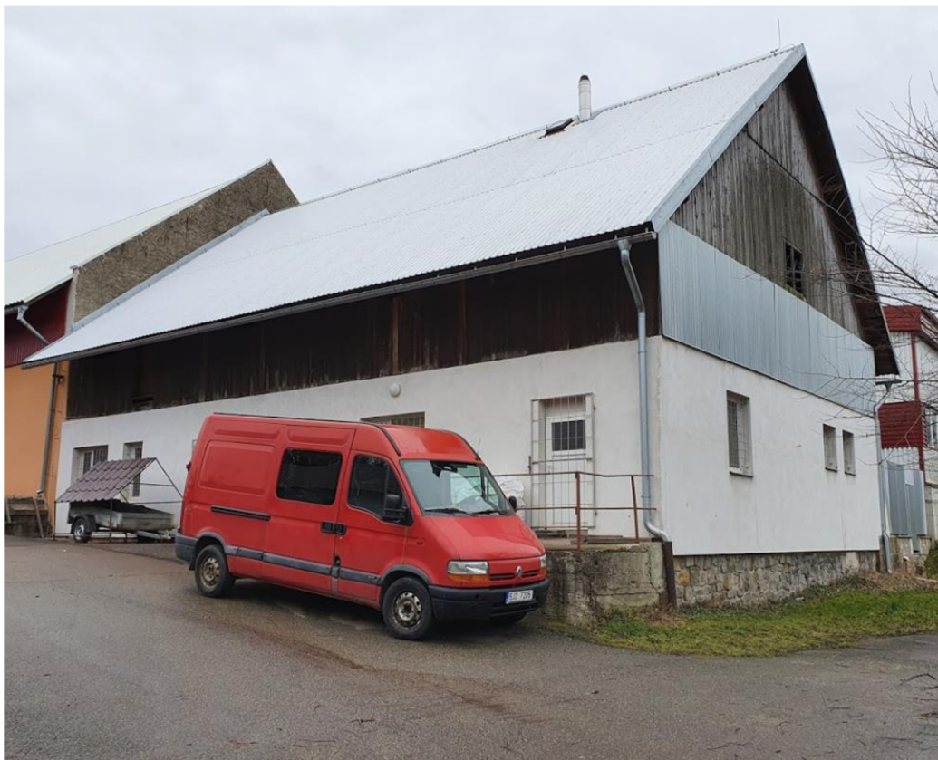
Obr. 50 Exteriér výrobní dílny 2.
