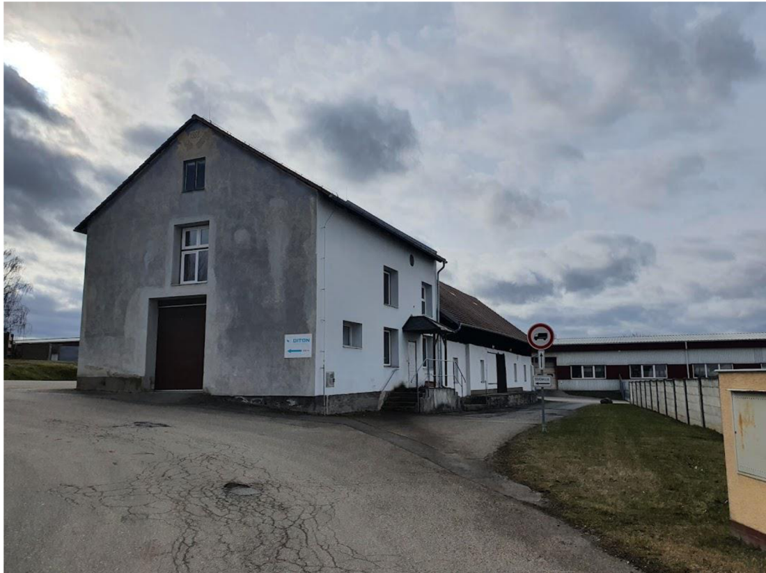
Obr. 59 Exteriér výrobní dílny 3.
