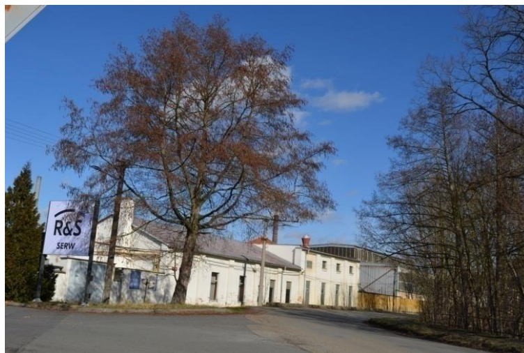
Obrázek č. 55: Objekt společnosti SERW a bývalých Sedleckých železáren
