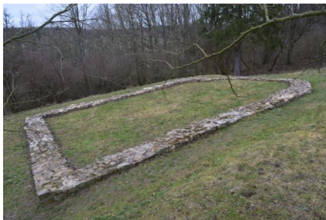
Obrázek č. 37: Zachovalé základy kostela sv. Vavřince
