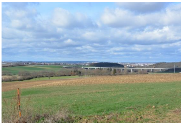
Obrázek č. 42: Pohled na dálnici D5 od nového hřbitova
