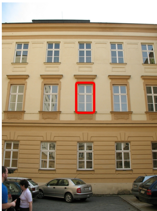
Obr. 16 Umístění kamery – pohled ze dvora PřF
