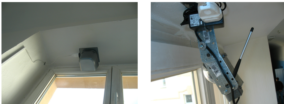
Obr. 15 Instalace kamery do okna na katedře
