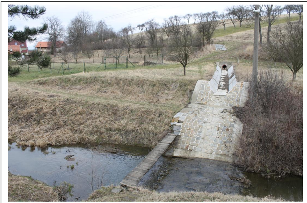
Obr. 43: Odvodňovací kanál v obci Suchá Loz (Petráš, 2017)
