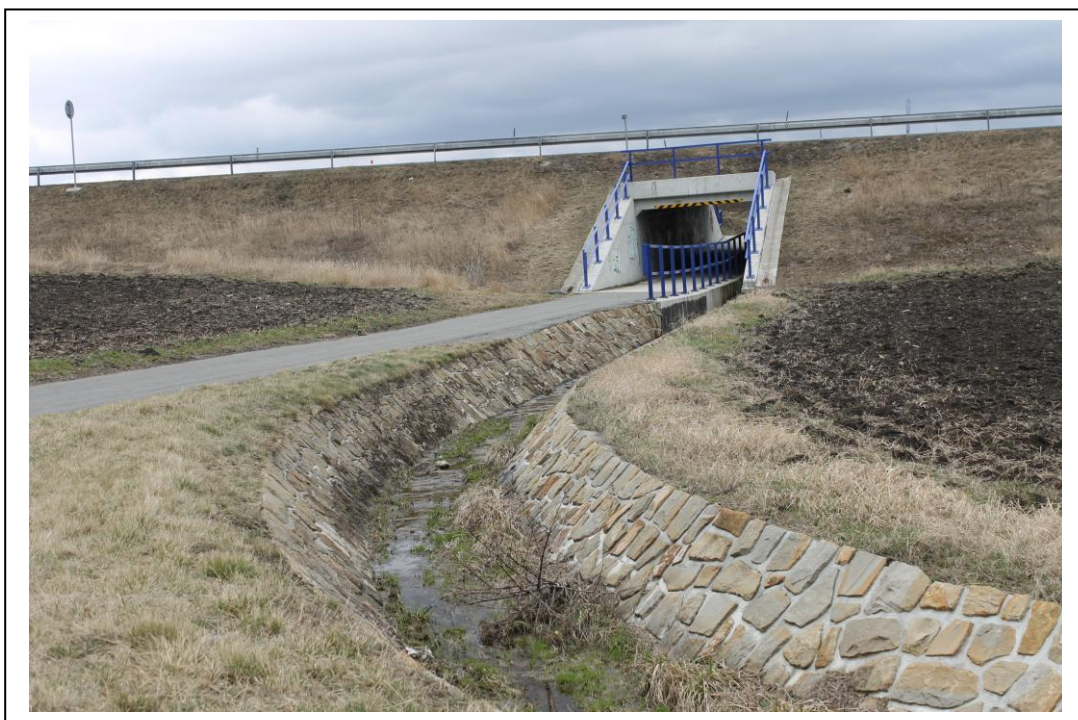
Obr. 36: Bezpečnostní odjezd pro cyklisty a odvodňovací kanál vybudovaný z plánu společných zařízení ( Petráš, 2017 )
