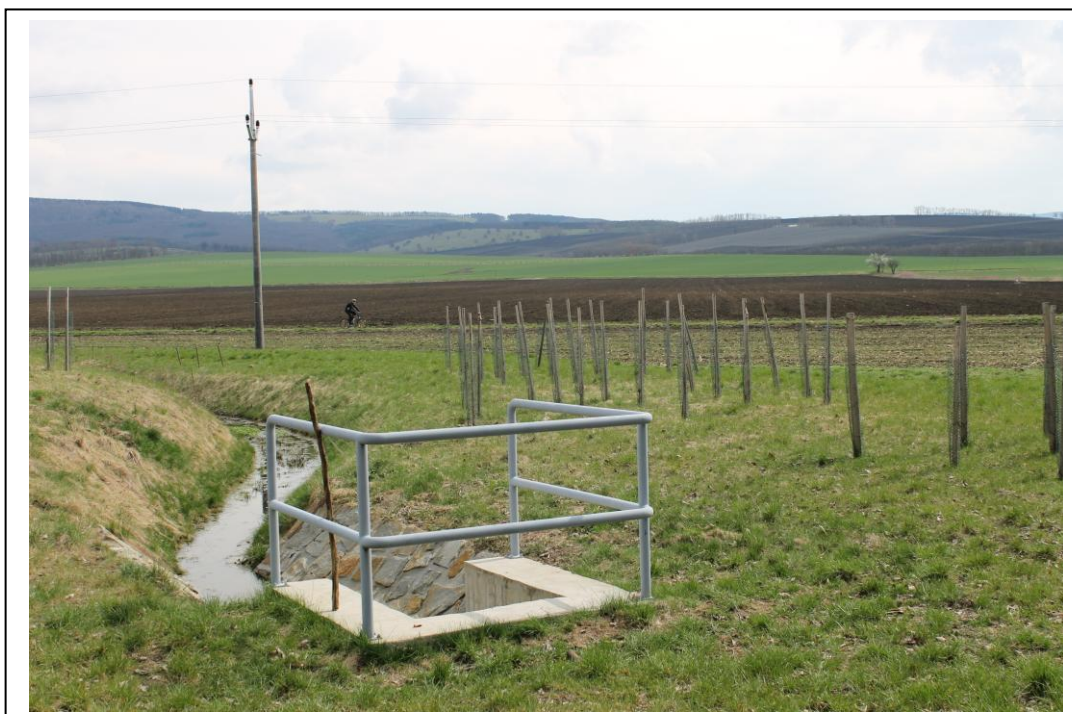
Obr. 40: Odvodňovací kanál a výsadba stromů na katastru obce Suchá Loz (Petráš, 2015)
