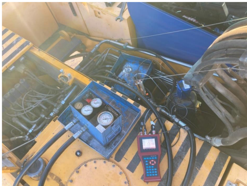
Obrázek 23 Zapojení analogového měřidla OTC H50 a digitálního měřidla Hydrotechnik MultiSystem 5060 do měřeného hydraulického obvodu otoče nástavby rypadla
