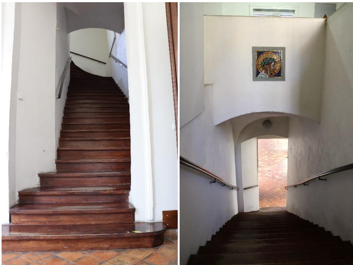
Obr. č. 16 – Schodiště Miserere
