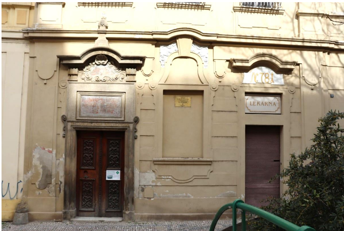
Obr. č. 21 – Vlevo dřívější nemocniční vstup (fortna) v ulici U Milosrdných. Vpravo dřívější vstup do lékárny
