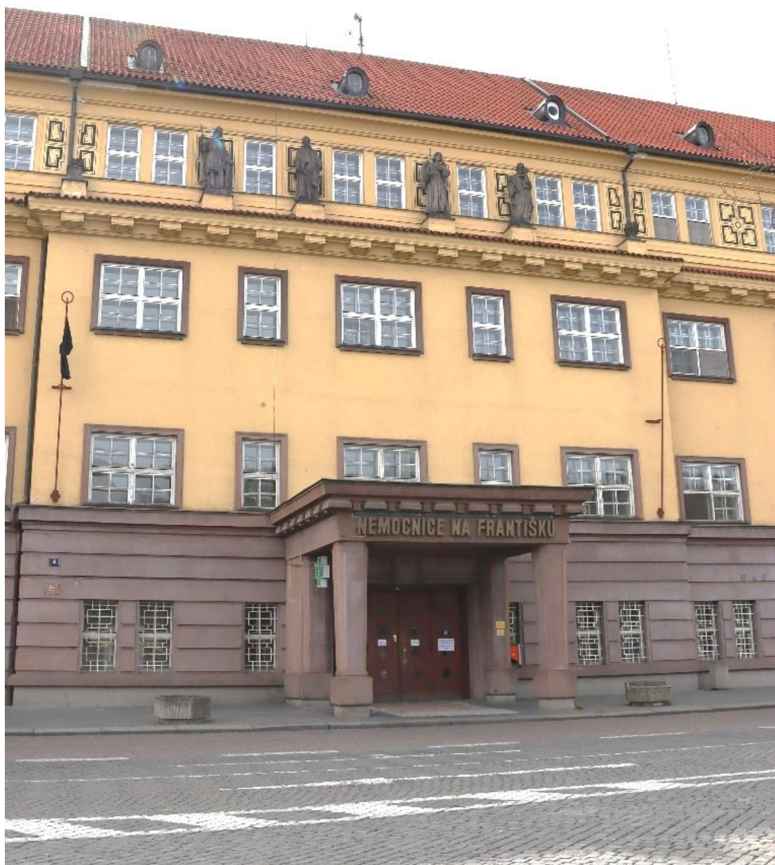
Obr. č. 25 – Současný vchod do nemocnice
