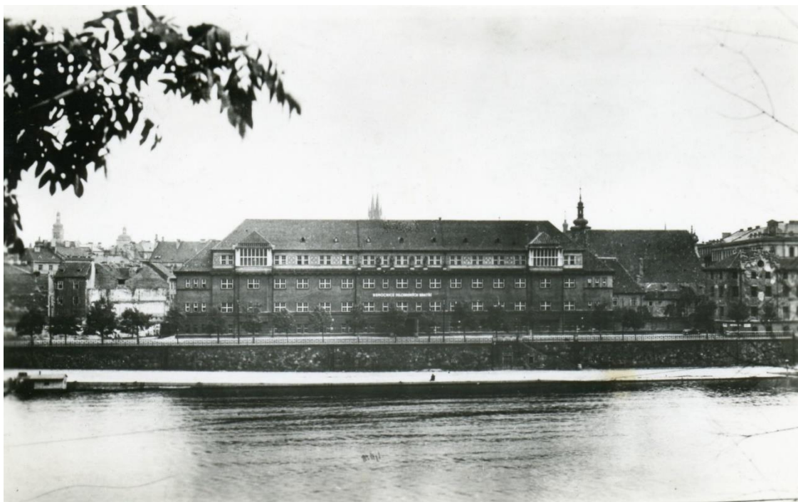
Obr. č. 8 – Pohled na nové nemocniční křídlo od Vltavy, ještě s nápisem Nemocnice Milosrdných bratří nad vstupním portálem
