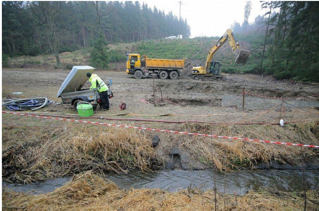
Obr. 7 Likvidační a sanační práce na území poškozeném po úniku motorové nafty z produktovodu u obce Knyk v roce 2014 (Plíhal, 2014)
