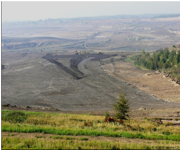
Obr. č.12. Těsnění dna budoucího jezera. Foto: PKÚ, s.p.
