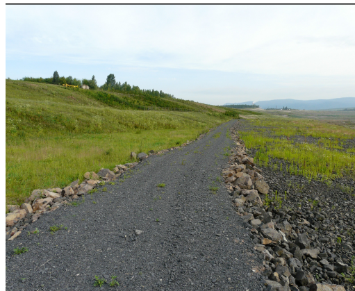
Obr. č.13. Obvodová komunikace je o šíři 4 m v celkové délce 9 815 metrů. Foto: PKÚ, s.p.
