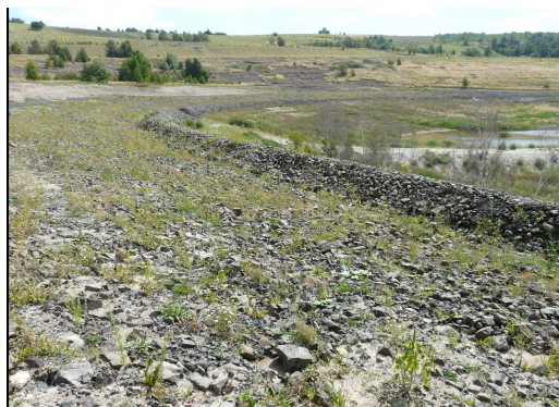
Obr. č.10. Vlnolamy a rozrážeče z lomového kamene. Foto: PKÚ, s.p.
