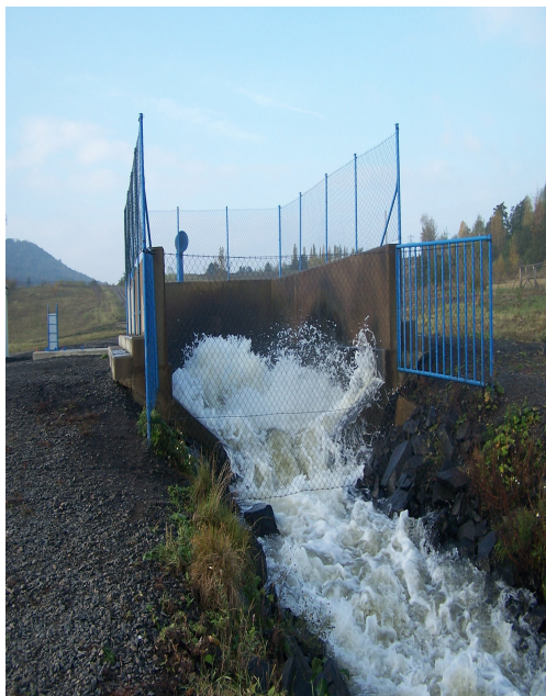
Obr. č.7. Regulační šachta s uklidňovací nádrží. Foto: Petra Mikulcová, říjen 2009.
