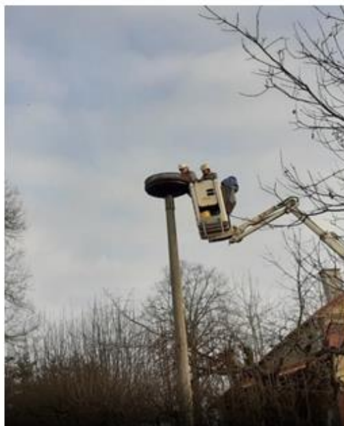
Obr 18: Instalace hnízdní podložkyVendolí (Krajský úřad Pardubického kraje, 2017)
