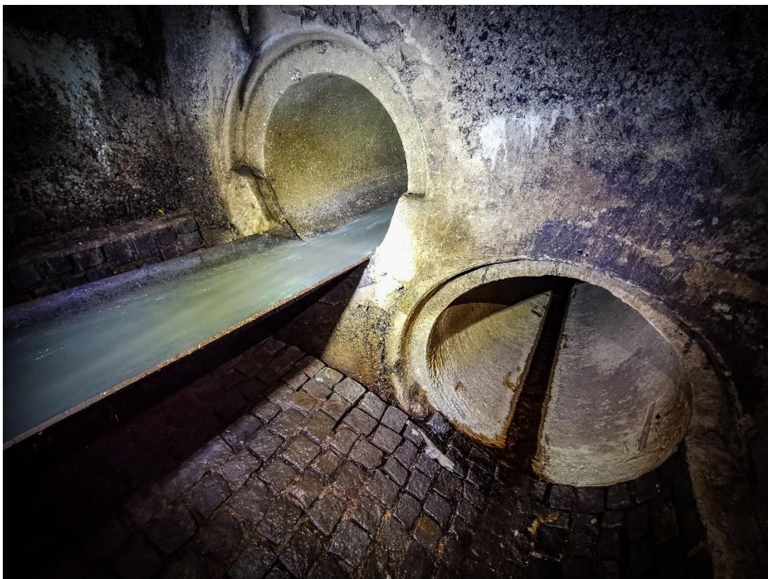
Příloha 17: Detail odlehčovací komory pod Mezibořím (zdroj: autor).
