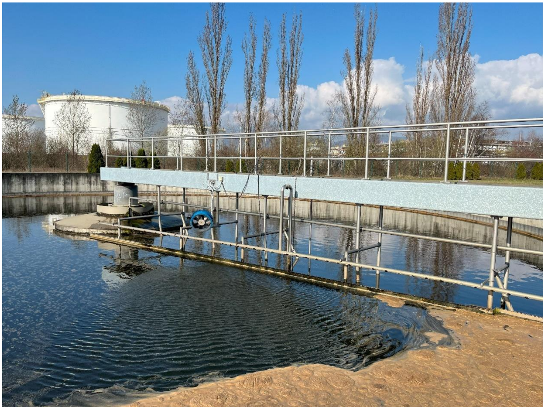
Příloha 14: Detail dosazovací nádrže (zdroj: autor).
