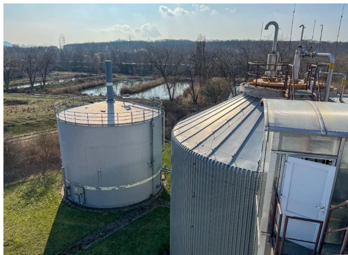
Obr. 19: Pohled z vyhnívacích nádrží na plynojem a okolí (zdroj: autor).
