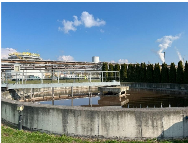
Obr. 15: Dosazovací nádrž ČOV Litvínov (zdroj: autor).
