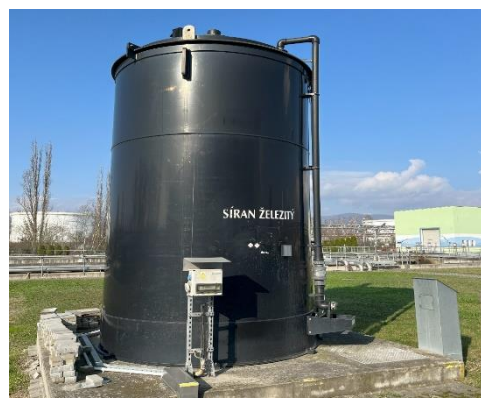
Obr. 21: Zásobník na síran železitý
