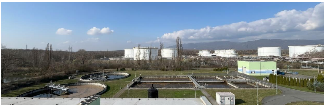
Obr. 13: Pohled na areál ČOV Litvínov (zdroj: autor).
