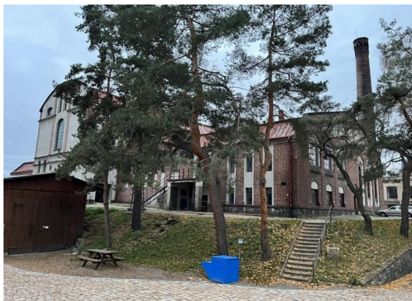
Obr. 1: Stará čistírna odpadních vod v Praze-Bubenči (zdroj: autor).
