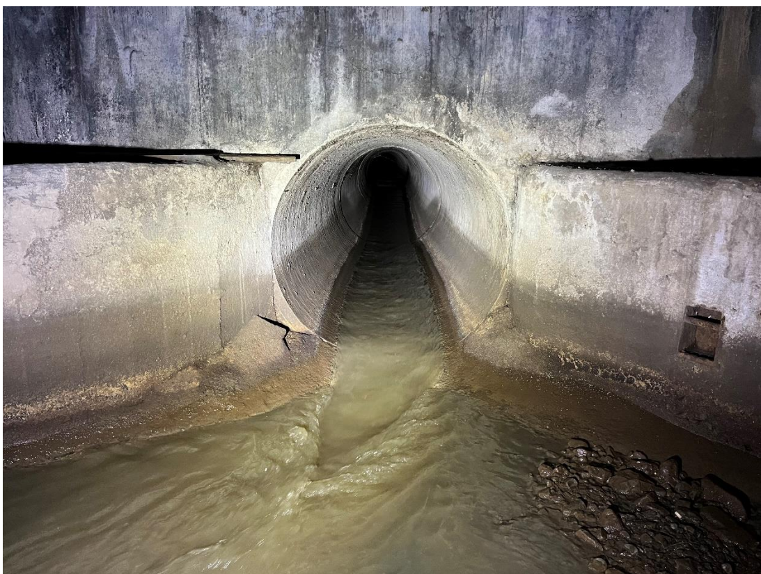
Příloha 18: Detail kanalizace pod Litvínovem (zdroj: autor).
