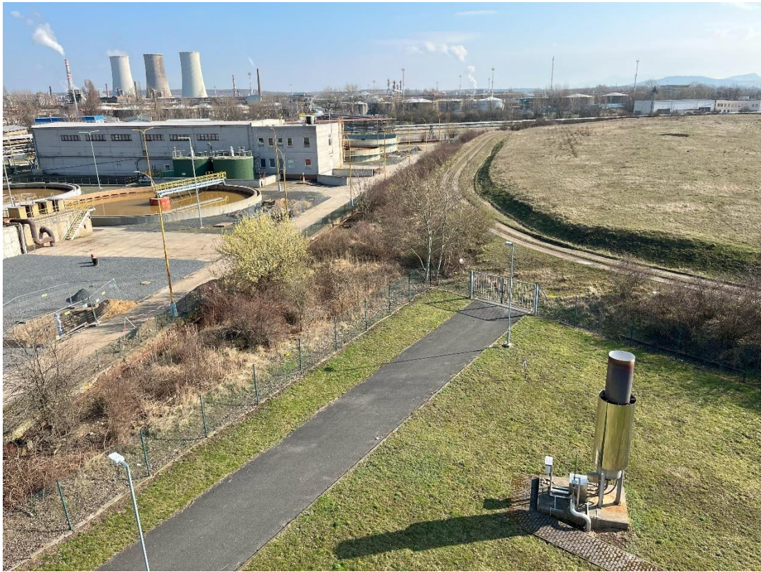
Příloha 13: Hořák na spalování plynu (zdroj: autor).
