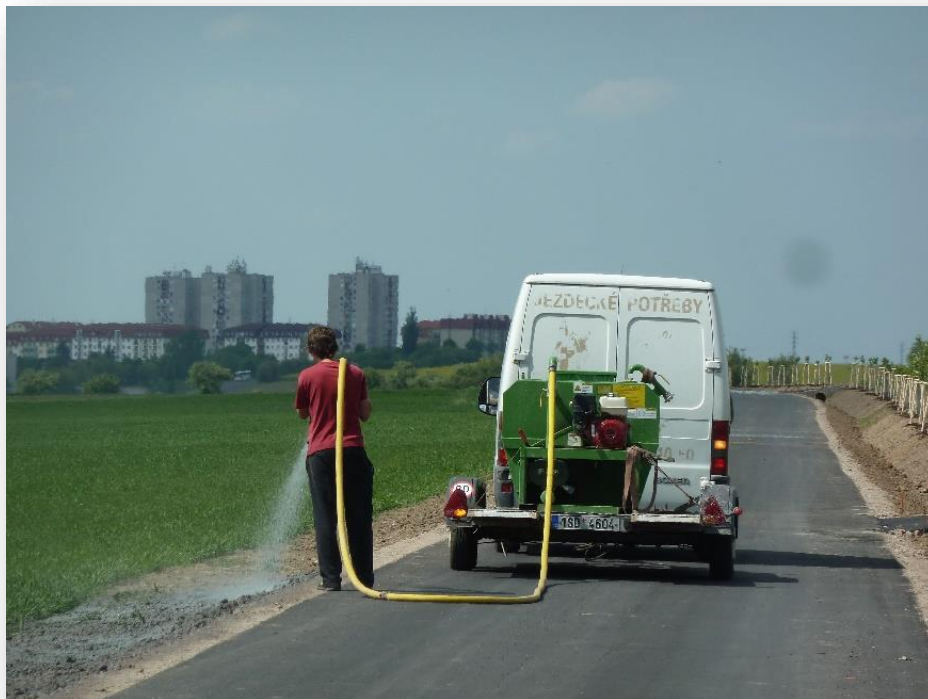
Obrázek 9: Ukázka aplikace hydroosevu na polní cestě HC 8
