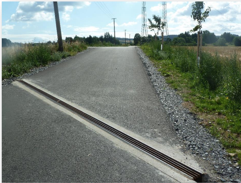
Obrázek 23: Ukázka ocelové svodnice se zabezpečením proti úrazům
