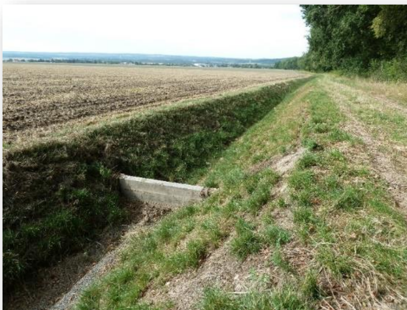
Obrázek 5: Záchytný příkop s dřevěným dubovým prahem
