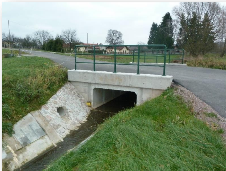
Obrázek 11: Rámový propustek přes potok Kurvice
