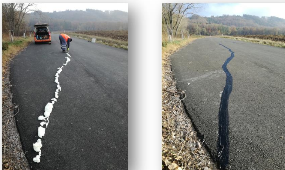
Obrázek 26: Ukázka vyspravení popraskaného asfaltového krytu komunikace
