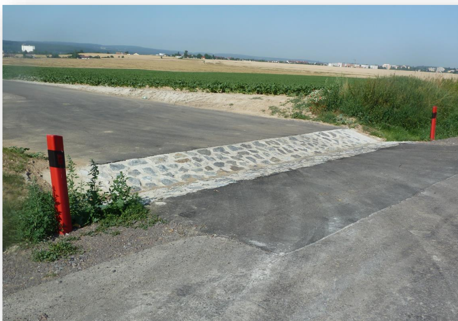
Obrázek 8: Suchý brod a správně instalované směrové sloupky
