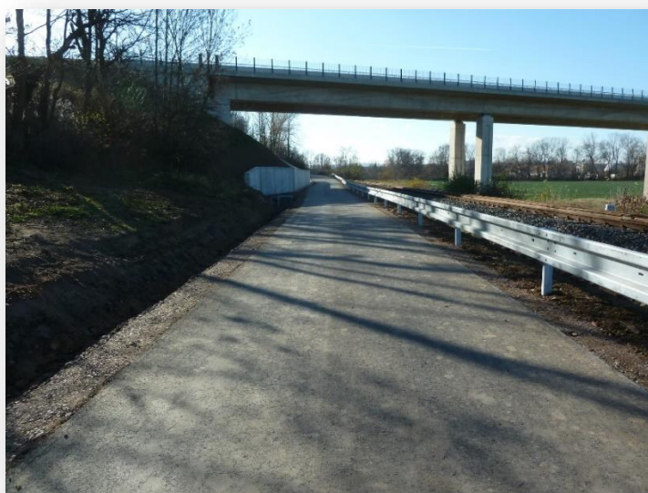
Obrázek 15: Polní cesta C9 pod mostem chrudimského obchvatu
