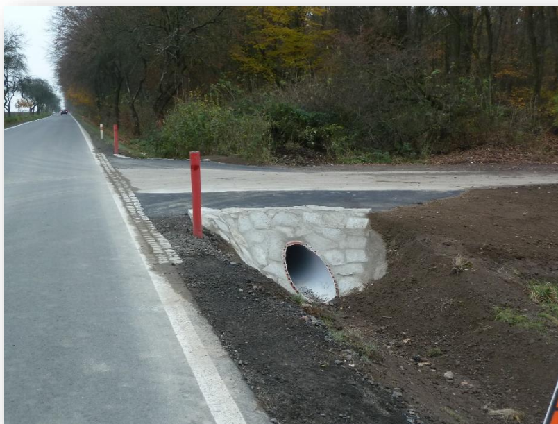
Obrázek 25: Opravený nastavený propustek s dvouřádkem žulových kostek
