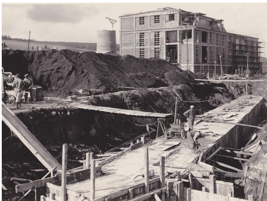
Příloha č.14: Areál národního podniku Perla, bavlnářské závody, Ústí nad Orlicí, závod 02 Česká Třebová, stavba teplárny a komína v roce 1961, archiv V. Jedličky.
