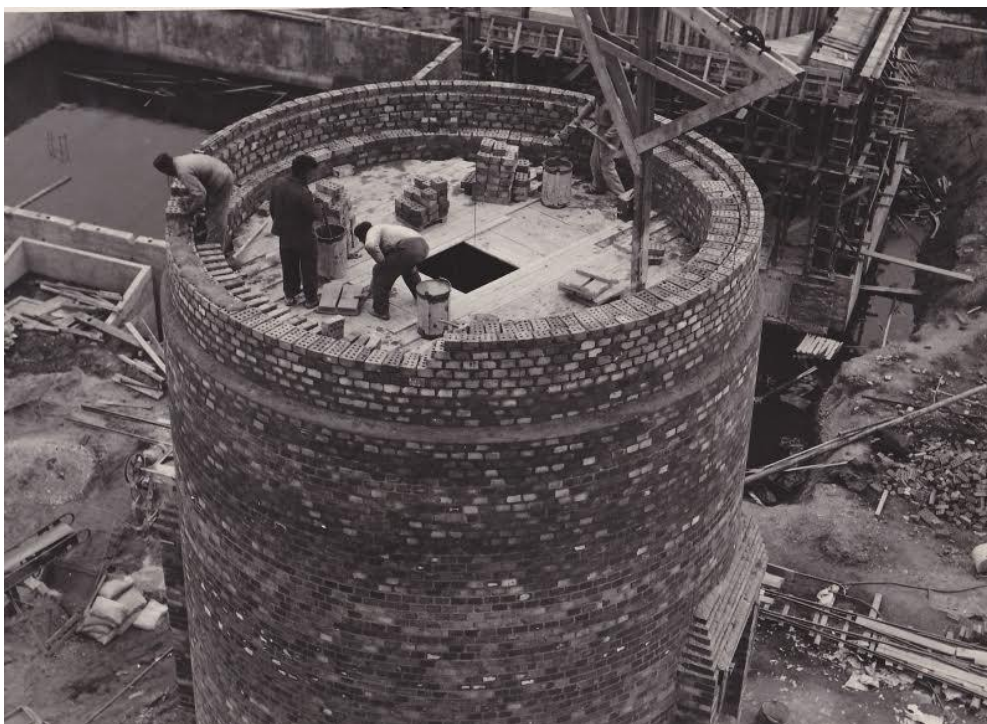
Příloha č.15: Areál národního podniku Perla, bavlnářské závody, Ústí nad Orlicí, závod 02 Česká Třebová, stavba teplárny a komína v roce 1961, archiv V. Jedličky.
