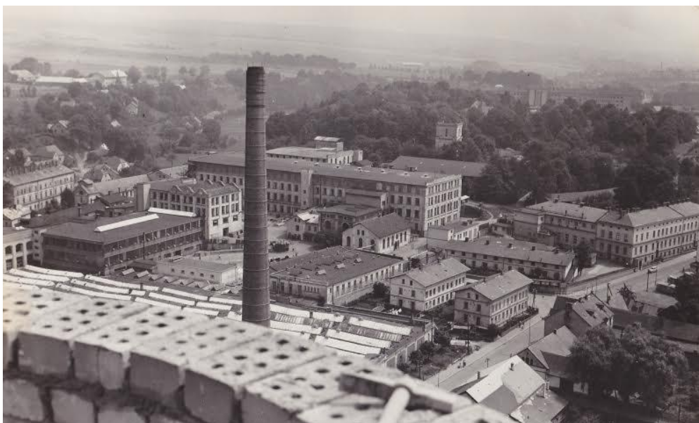
Příloha č.16: Areál národního podniku Perla, bavlnářské závody, Ústí nad Orlicí, závod 02 Česká Třebová, pohled na celý areál, 70. léta 20. století, archiv V. Jedličky.
