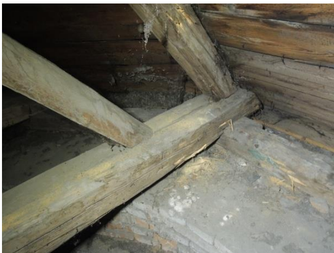
Obr. 43: VT poškozený biotickými činiteli
