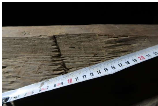
Obr. 48: Šířka stopy po opracování hlavátkou
