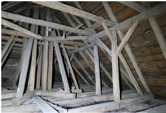
Obr. 32: Krov hlavní lodi – příčná vazba se vzpěrami, v pozadí konstrukce sanktusníku (věžičky)
