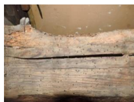
Obr. 25: Anobium punctatum – výletové otvory (thermosanace.cz)
