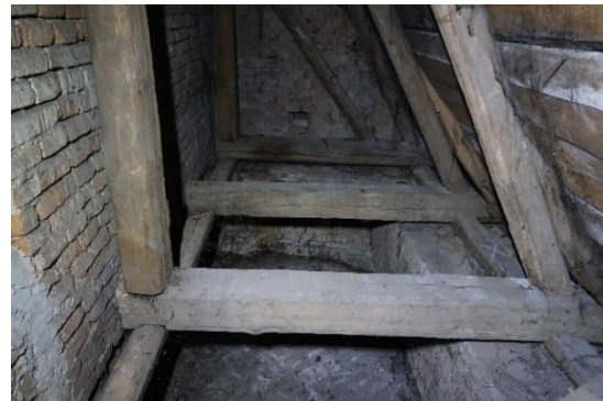
Obr. 33: Krov hlavní lodi – pultová část v místě věže
