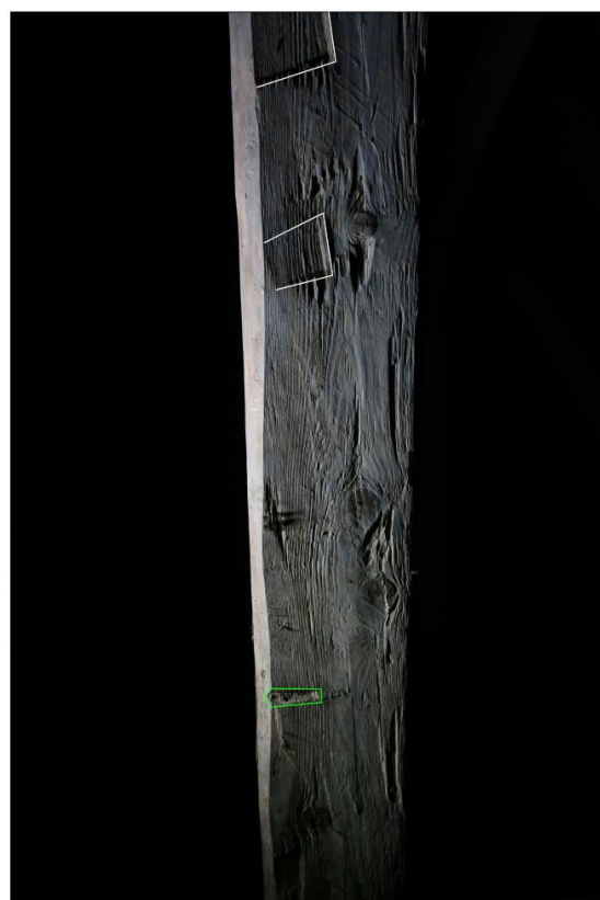
Obr. 50: Stopa po vrubování (zelená) a hrubování (bílá) hlavátkou
