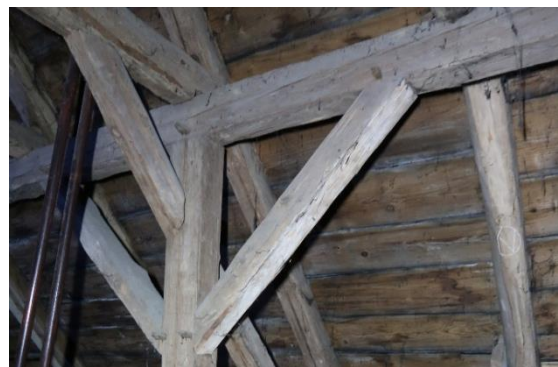
Obr. 30: Krov hlavní lodi – čepované spoje pásků podélného vázání
