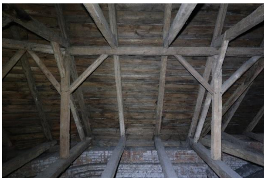
Obr. 29: Krov presbytáře – západní podélné vázání
