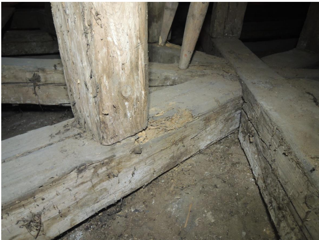
Obr. 45: VT věžičky napadený tesaříkem a hnilobou
