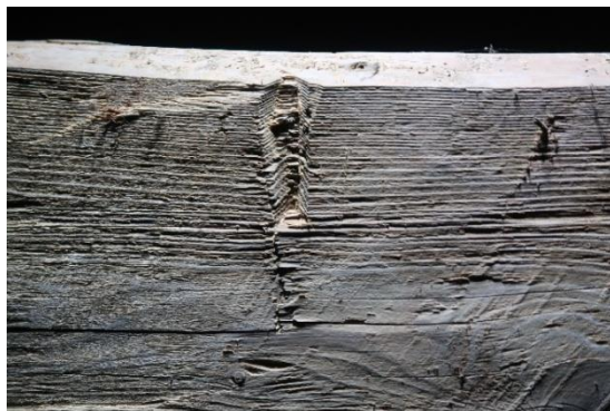
Obr. 47: Vrub po párovém vrubování
