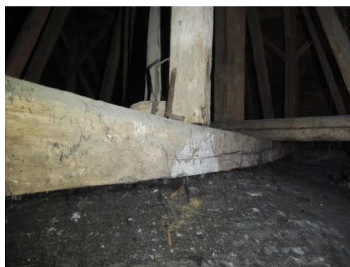
Obr. 39: Zdeformovaný VT vlivem hmotnosti věžičky
