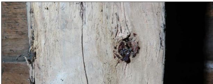
Obr. 52: Suk krokve 4. vazby (západ) s pryskyřičnými kanálky
