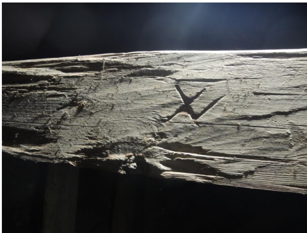
Obr. 51: Tesařské montážní značení východního sloupku 15. vazby
