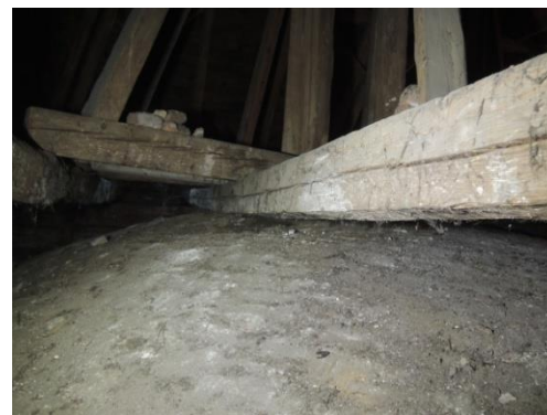
Obr. 41: VT tlačící na klenbu
