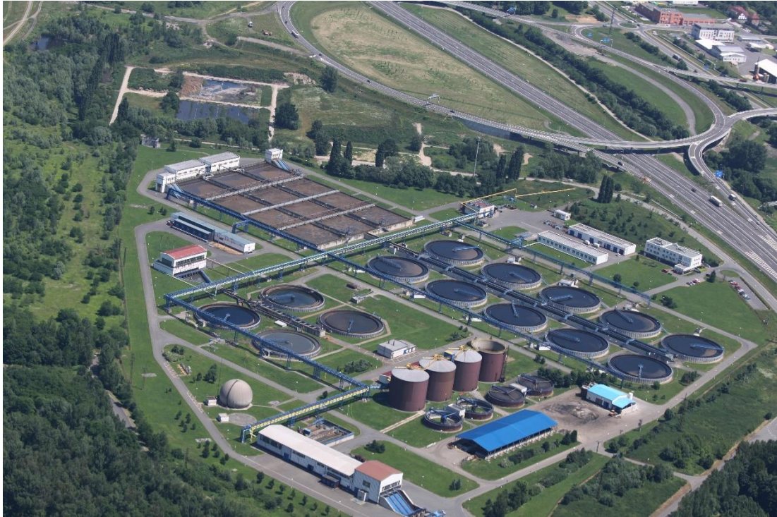
Obr.2. Ústřední čistírna odpadních vod, Praha (PVK.cz, 2021)
