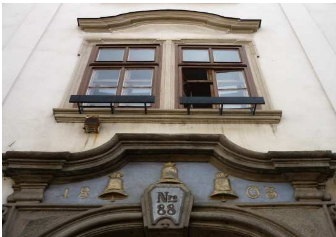
Obrázek č. 2: Detail portálu domu č. p. 88 v Pražské ulici
