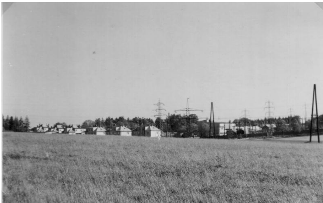
Obr. 10: Rok 1958 – pohled na rozvodnu a domy v poklesu
