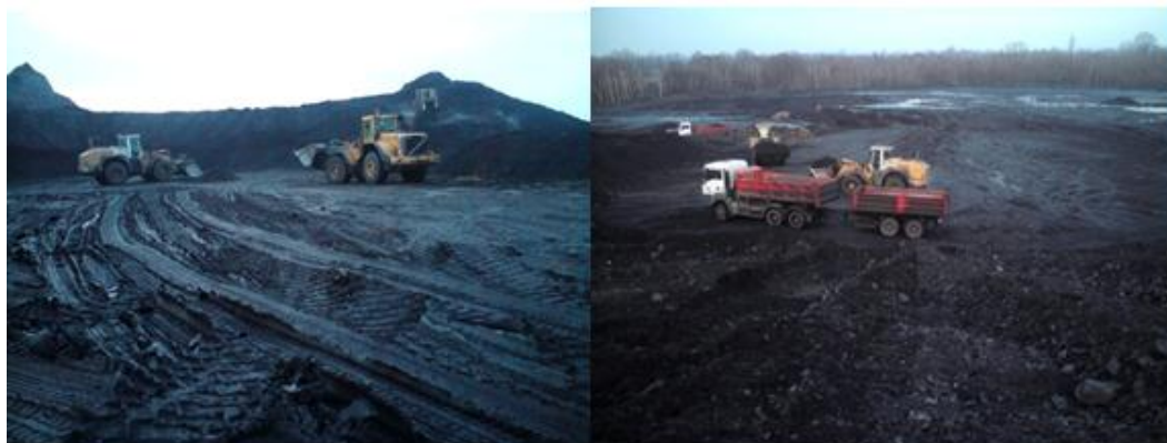
Obr. 4: Těžba hlušiny pomocí kolových nakladačů
