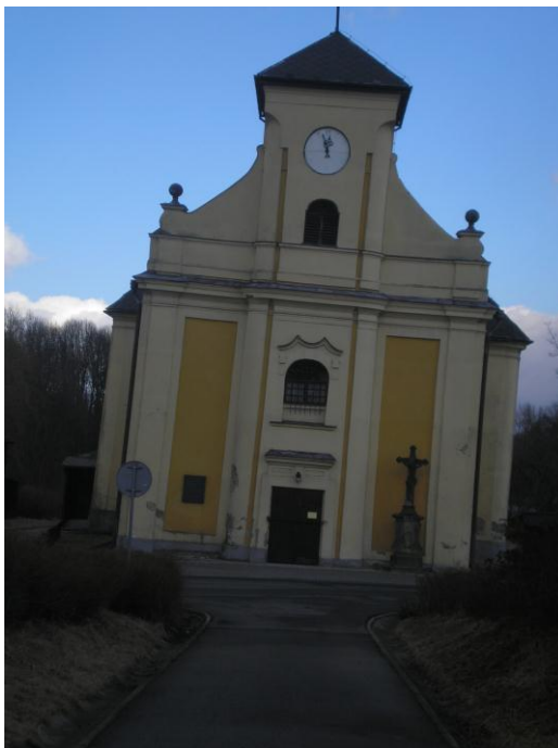
Obr. 2 : Viditelné poškození půd - klesání terénu, kostel Karviná - Doly Zdroj: Vlastní
