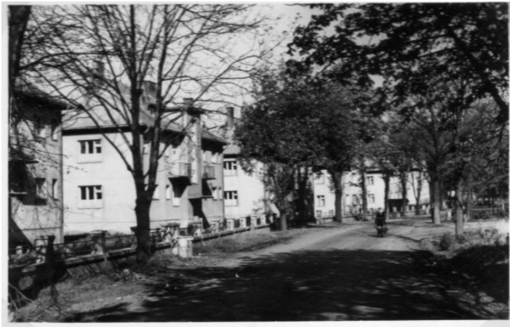
Obr. 9: Rok 1958 – bývalé bytové jednotky na území Horní Suché - Podlesí
