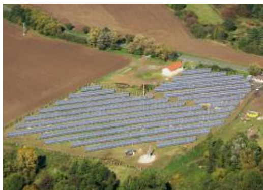
Obr. 7.2-3 Sluneční elektrárna Habřina
