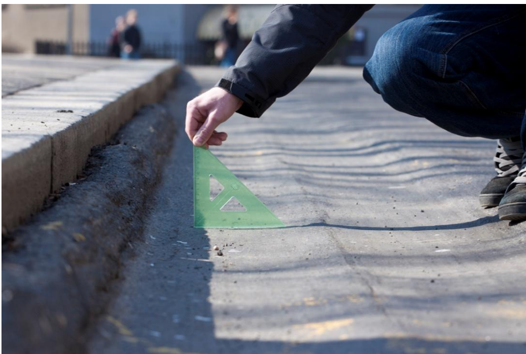
Příloha č. 9 - Obr. 11 – Vytlačení materiálu – vytlačení materiálu autobusy MHD
