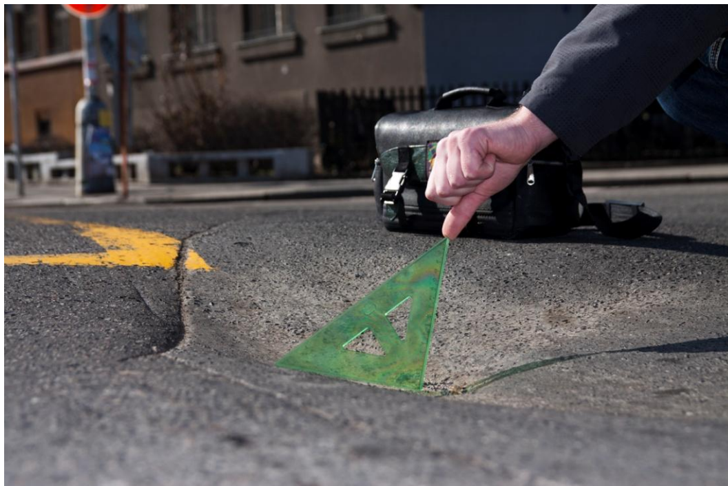
Příloha č. 8 - Obr. 10 – Propadlina – dno fotobrašny vyznačuje původní výšku vozovky
