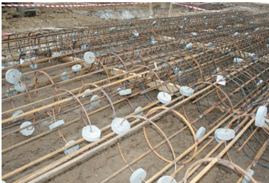
Obr. 5.5 Distanční kolečka na armokoších [20]
