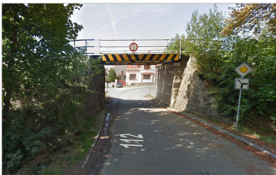
Obrázek 45 Snížený železniční podjezd [46]
