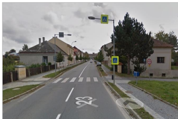
Obrázek 42 Přejezd cyklotrasy přes silnici I/23 [46]
