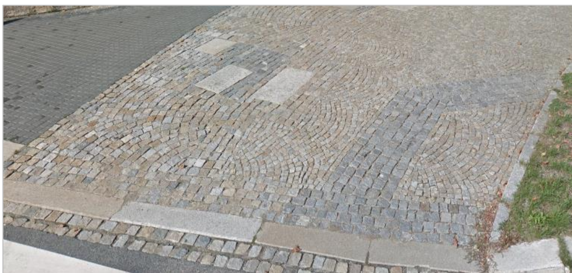
Obrázek 35 Chybějící varovný pás [Zdroj: vlastní]
