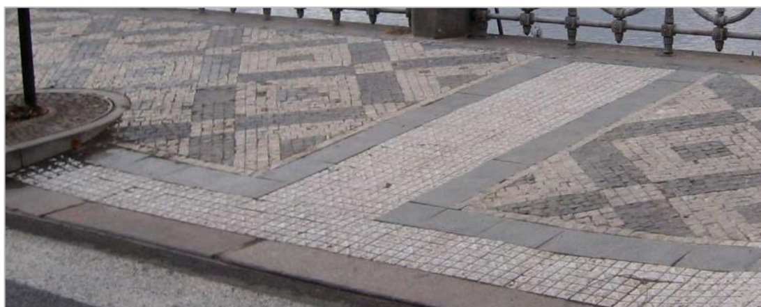
Obrázek 36 Správné provedení hmatových úprav [50]
