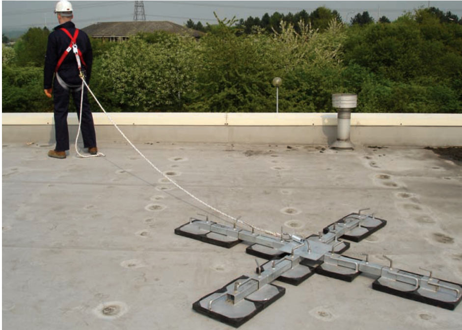
Obr. 6.18 Příklady použití přenosných střešní kotvicích prvků na rovných střechách [23]
