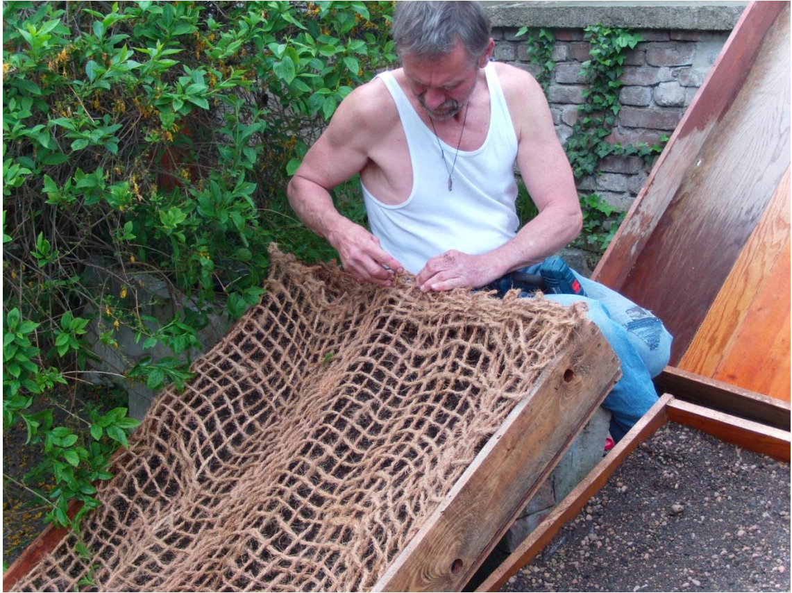
Obr. 16: Zadržný systém - kokosová síť 400g/m 2 tl. 6 mm.
