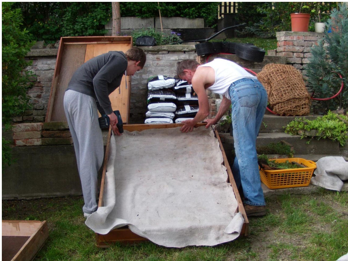
Obr. 12: Sestavování modelu extenzivní šikmé vegetační střechy sklonitosti 25°. Aplikace stavební geotextilie s konzultantem Ing. Balíkem.
