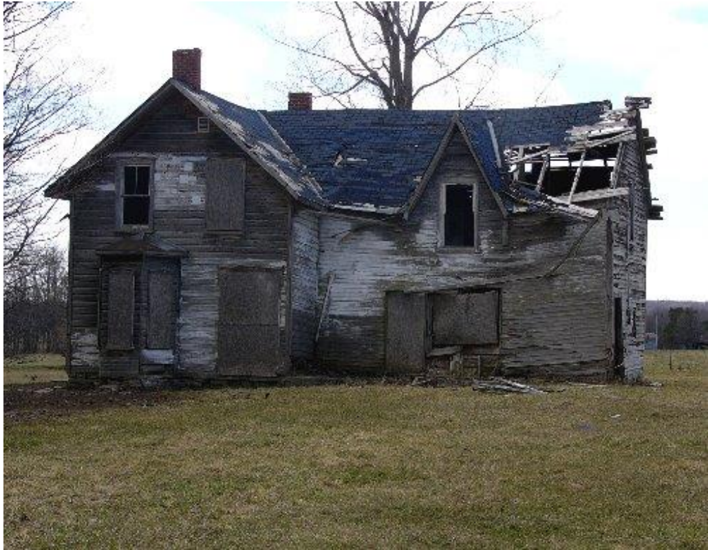
Photo 6, „The Jack´s House“ (Mike, 2012)
