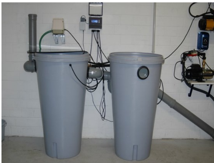
Obrázek 2 - Domovní ČOV – AS-GW/AQUALOOP 6
