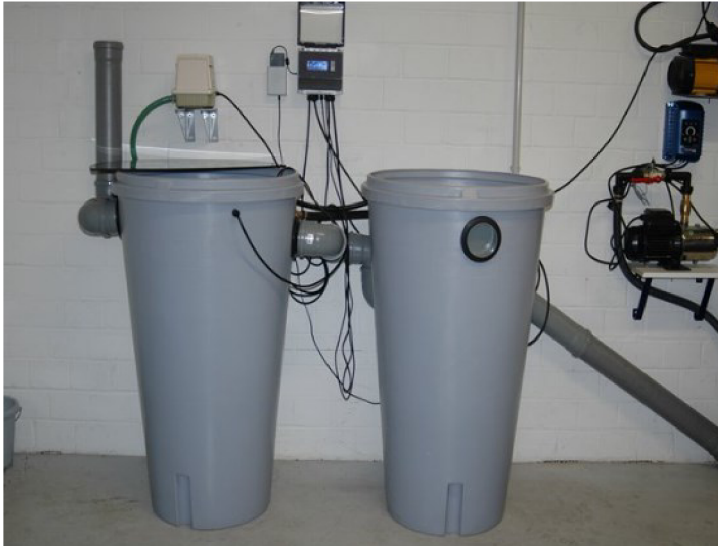
Obrázek 2 - Domovní ČOV – AS-GW/AQUALOOP 6
