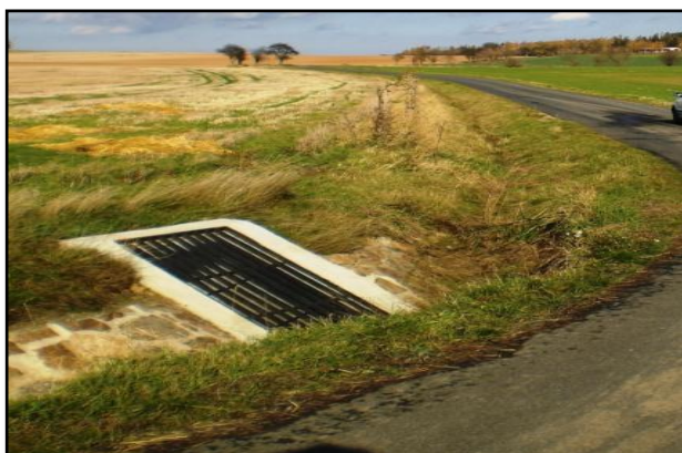
Obr. 41: Opevněný příkop s trubním propustkem u hlavní polní cesty C2
