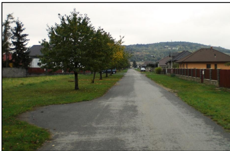
Obr. 17: Vedlejší polní cesta P7 s výhybnou
