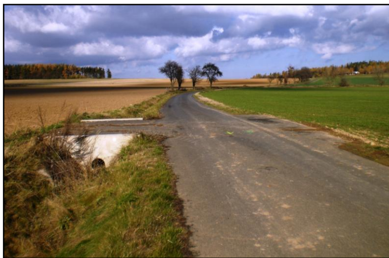
Obr. 41: Opevněný příkop s trubním propustkem u hlavní polní cesty C2
