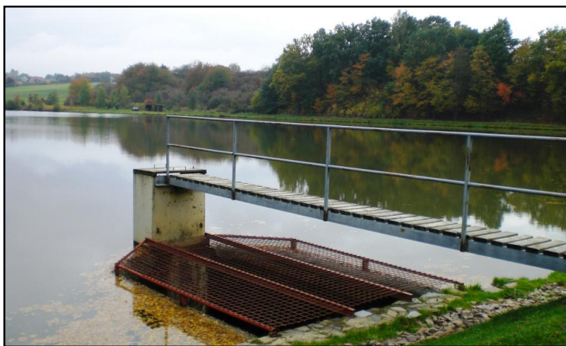
Obr. 70: Bezpečností přeliv a výpustný objekt rybníka Katovna
