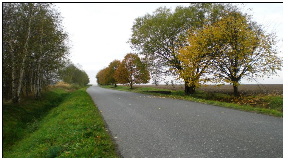
Obr. 66: Hlavní polní cesta S 5 ve směru k obci Zavadilka
