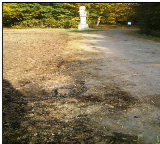
Obr. 29: Narušený povrch vedlejší polní cesty OC 2
