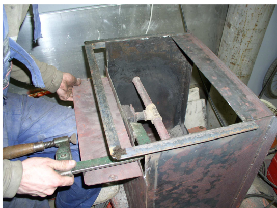
Obr. III - Zhotovení pomocné konstrukce, která bude umožňovat šroubové spojení kamen s výměníkem.
