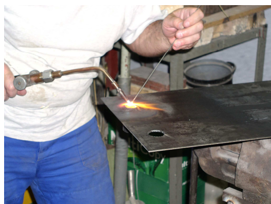
Obr. IV - Přivaření vodních přípojek.
