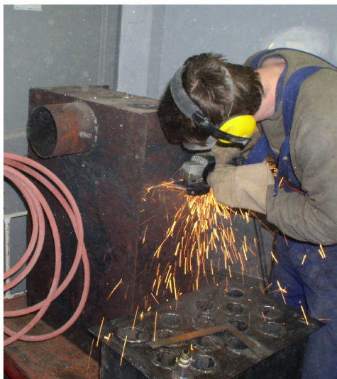
Obr. I - Odřezání kouřové komory.
