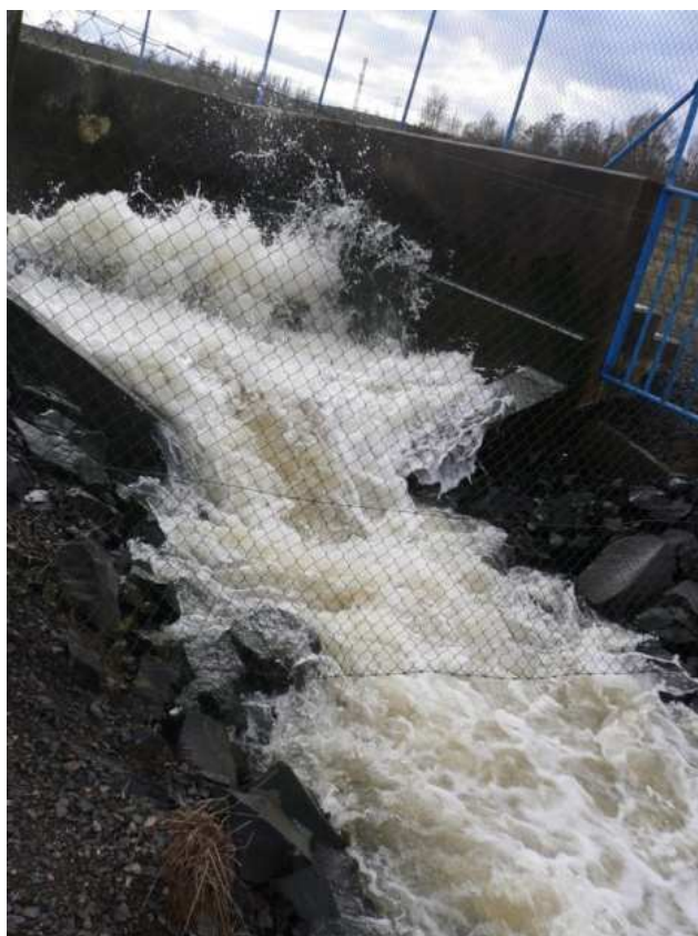
Příloha č. 22: Voda z přivaděče řeky Ohře (foto Martinková, 2010)
